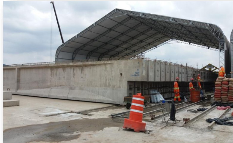
Central de Pré-Moldados para Lotes 2 e 4.
