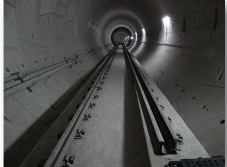
Execução Via permanente Túnel Singelo
