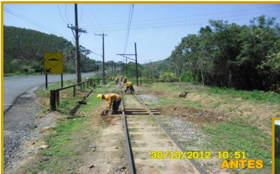
**Troca de dormentes, colocação de lastro e construção de canaletas de drenagem**
