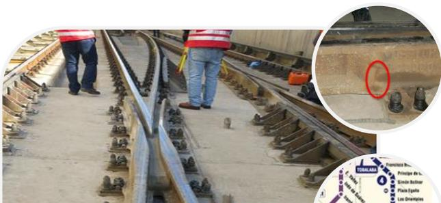
Fisura detectada durante inspección nocturna de vías en Línea 4
