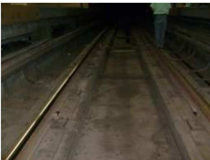
Figura 18 – Aplicação das conexões com Clips na via para monitorar a operação comercial.
