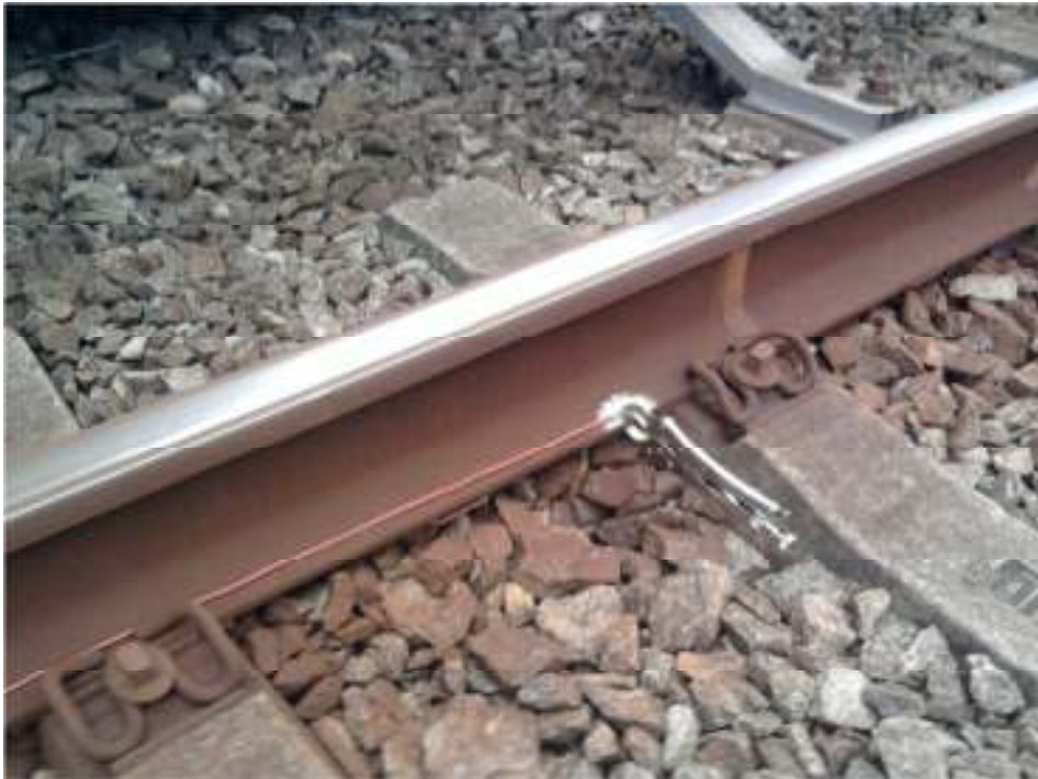
Figura 12 – Detalhe da conexão com alicate de pressão.
