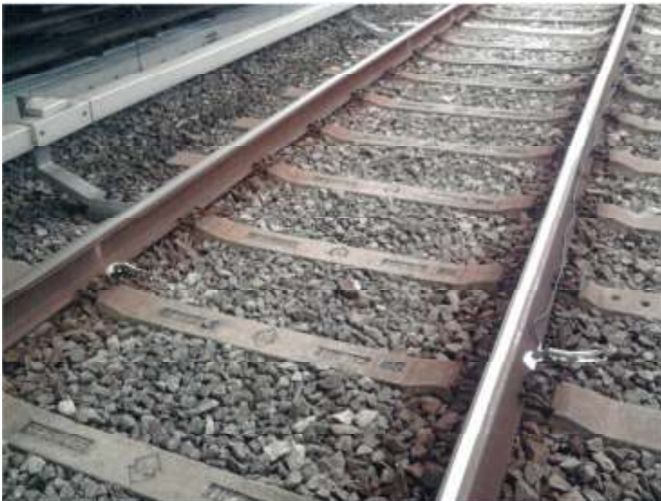
Figura 13 – Utilização de alicates de pressão para conexão dos cabos aos trilhos.
