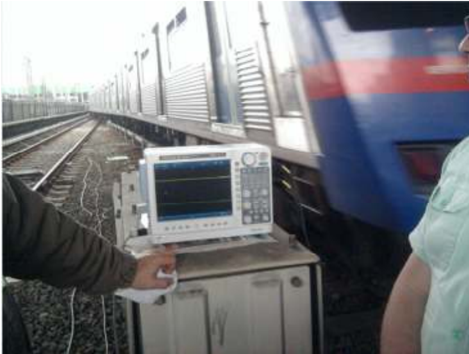
Figura 10 – Testes de imunidade à ruídos e interferências do trem.
