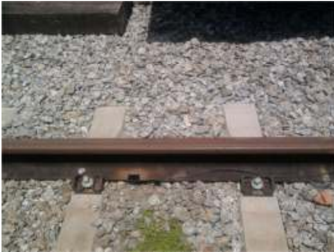
Figura 16 – Conexão utilizando Clips aplicado na via em regiões de brita.
