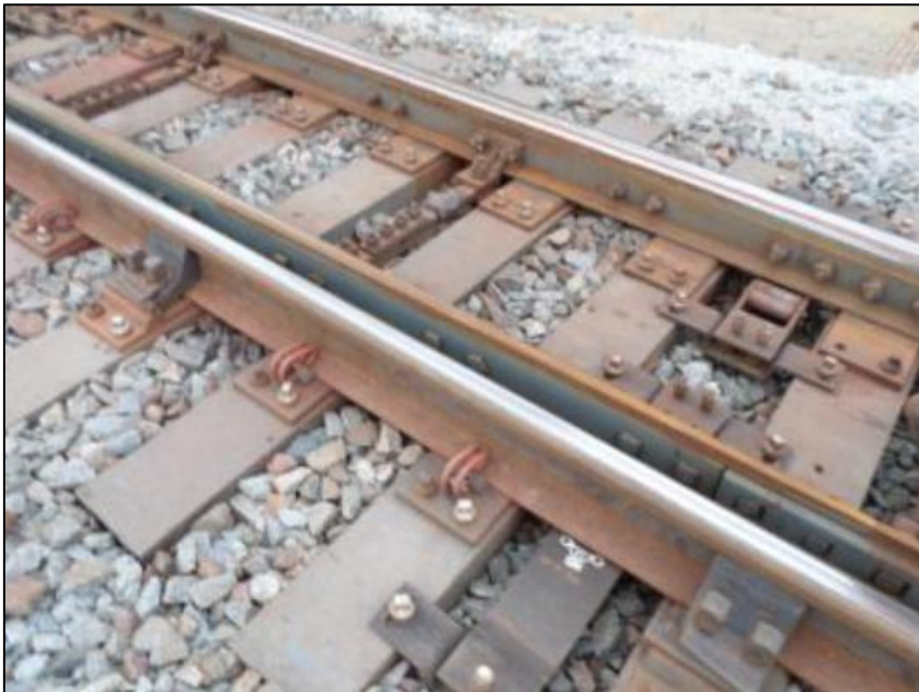
Figura 4 – Dormentes na região da agulha, AMV RH53.
