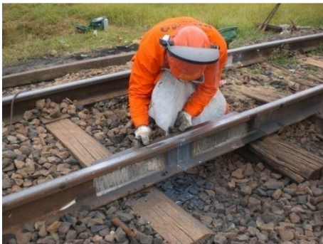
Figura 12 - Verificação do nivelamento e alinhamento após a solda (Thiago Viana, 2011)
