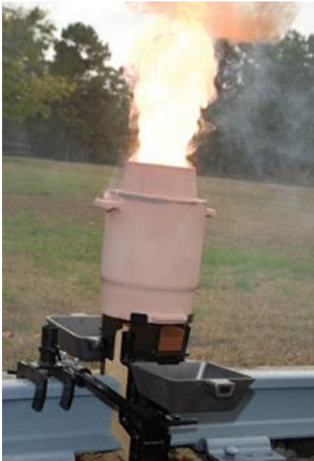
Figura 1 – Soldagem aluminotérmica [8]
