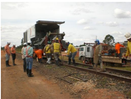
Figura 9 - Puxamento, alinhamento e nivelamento dos trilhos (Thiago Viana, 2011)
