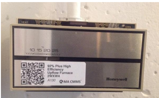
Figura 10 - Controlador de temperatura identificado por código matricial (Dutschke, 2014)
