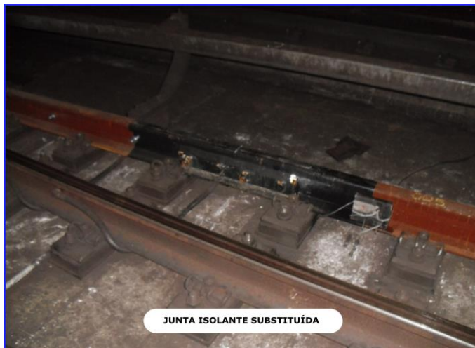
Figura nº17- Junta isolante substituída
