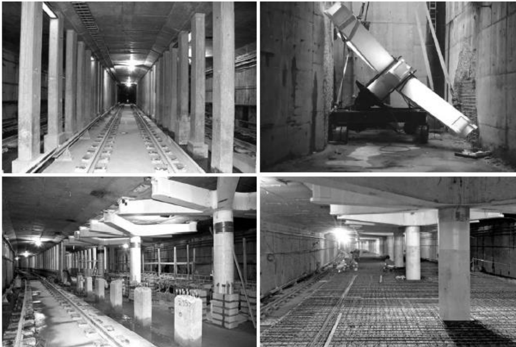
Figura 9 - Fotos da obra (Fonte: acervo JBMC Arquitetura e Urbanismo)
