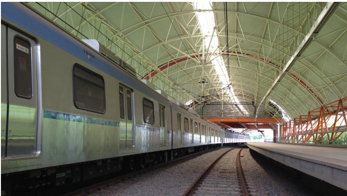
Figura 3 – Foto da estação existente ACN-L1 (Fonte: acervo JBMC Arquitetura e Urbanismo)
