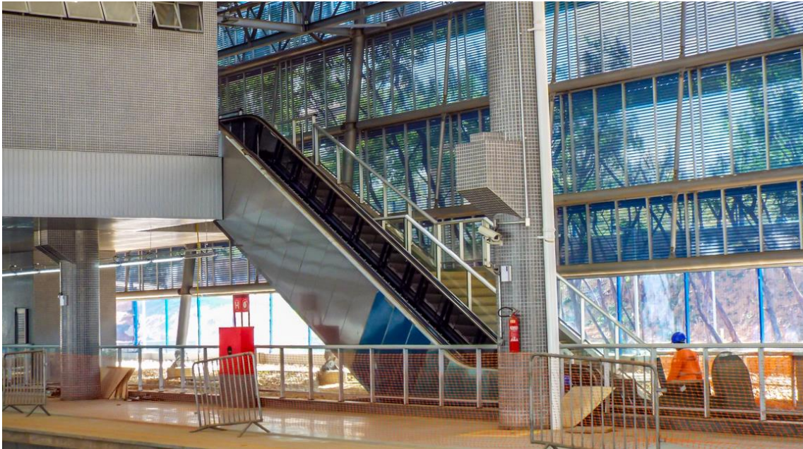
Figura 14 - Vista das Escadas rolantes aproveitadas no retrofit da Estação Acesso Norte - Linha 2 (Fonte: acervo JBMC Arquitetura e Urbanismo)
