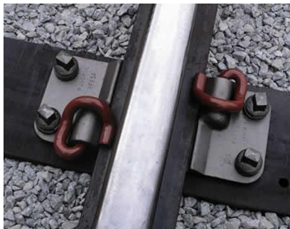
Figura 3: Grampos Pandrol presos em Trilho.
