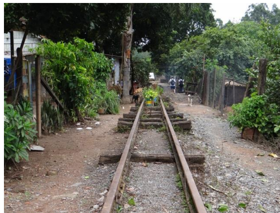
Figura 13: Trecho onde Possui Moradias.
