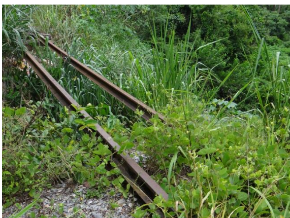
Figura 12: Trecho com Problemas Erosivos.
