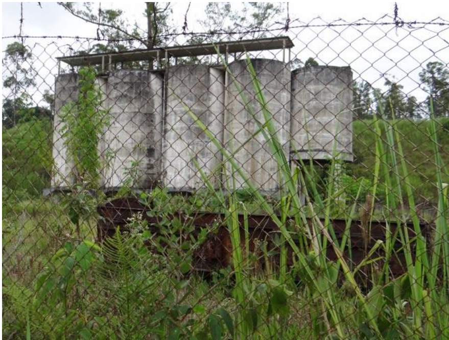
Figura 10: Vagonete Abandonado Dentro da Fabrica de Cimento em Perus. Fonte: (Autores, 2016).
