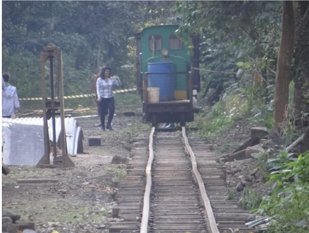
Figura 14: Via Flambada Próximo ao Pátio do Corredor. Fonte: (Autores, 2016).
