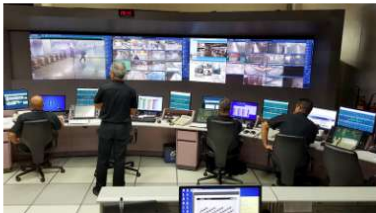
Centro de Supervisão da Segurança Pública - Metrô de São Paulo
