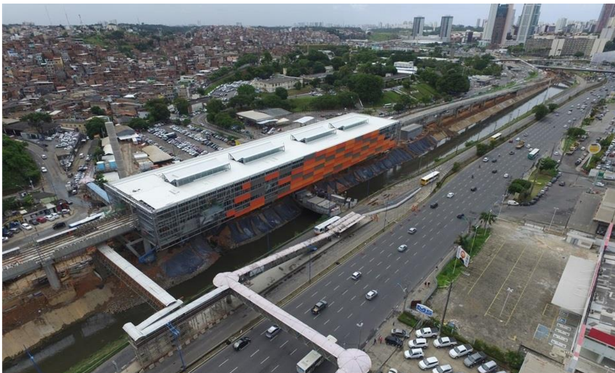
Figura 15 – Foto da Estação Detran em construção (Fonte: Skyscrapercity)
