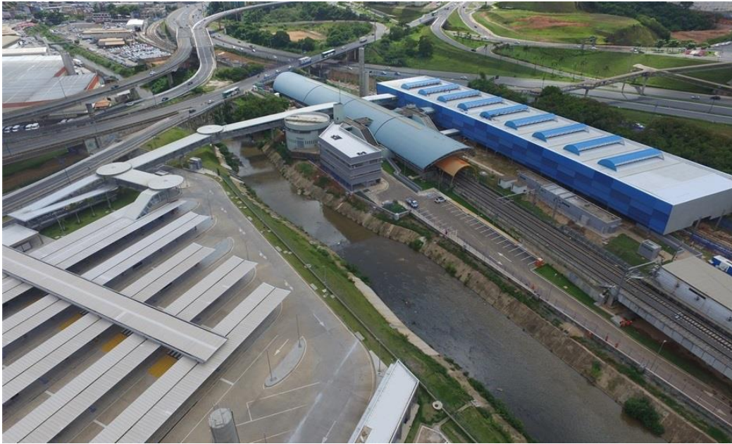
Figura 10 – Foto do complexo Acesso Norte em construção (Fonte: acervo do cliente)
