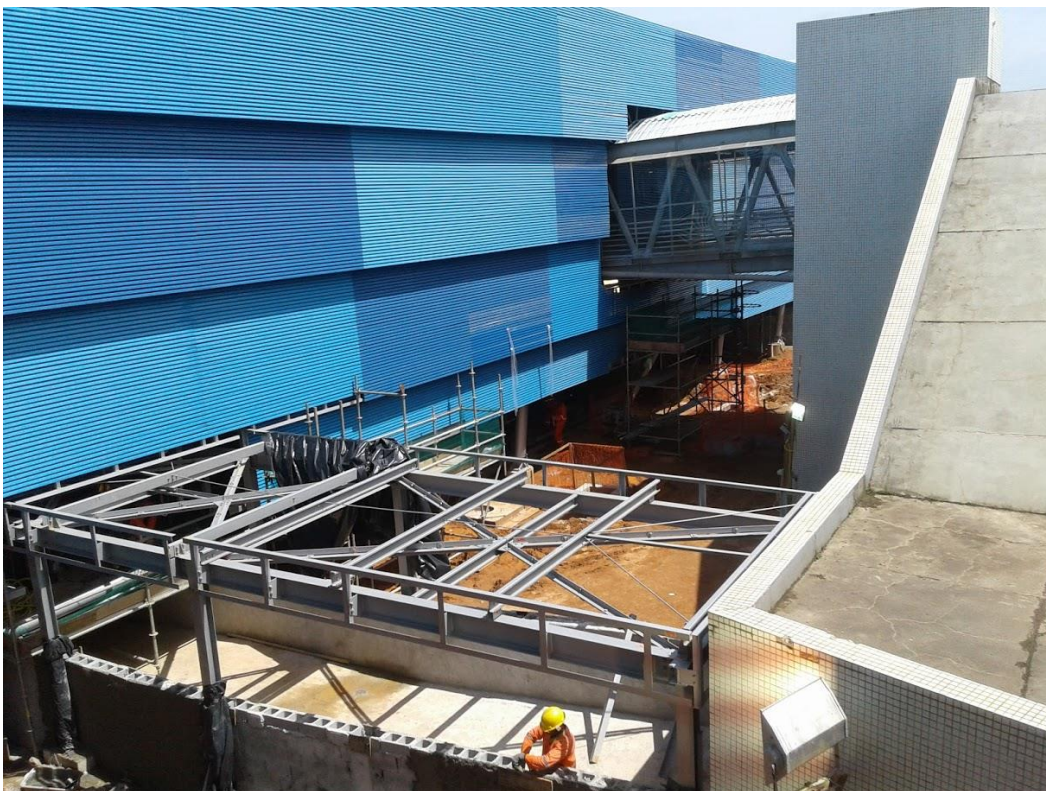
Figura 11 – Foto do complexo Acesso Norte em construção (Fonte: acervo do cliente)
