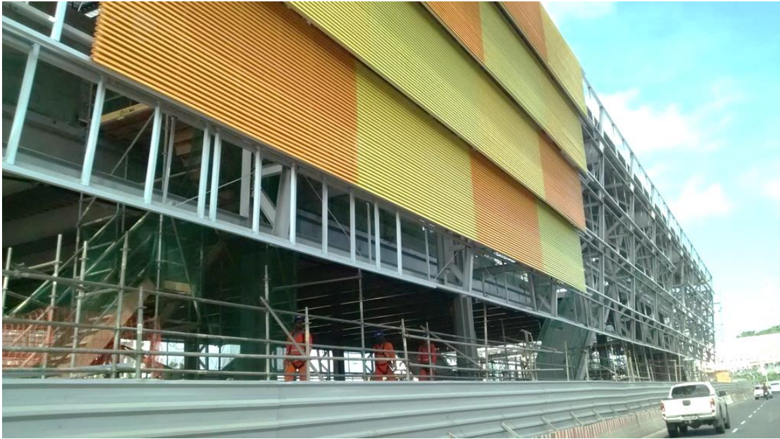
Figura 18 – Foto dos brises da Estação Iguatemi em construção (Fonte: Skyscrapercity)
