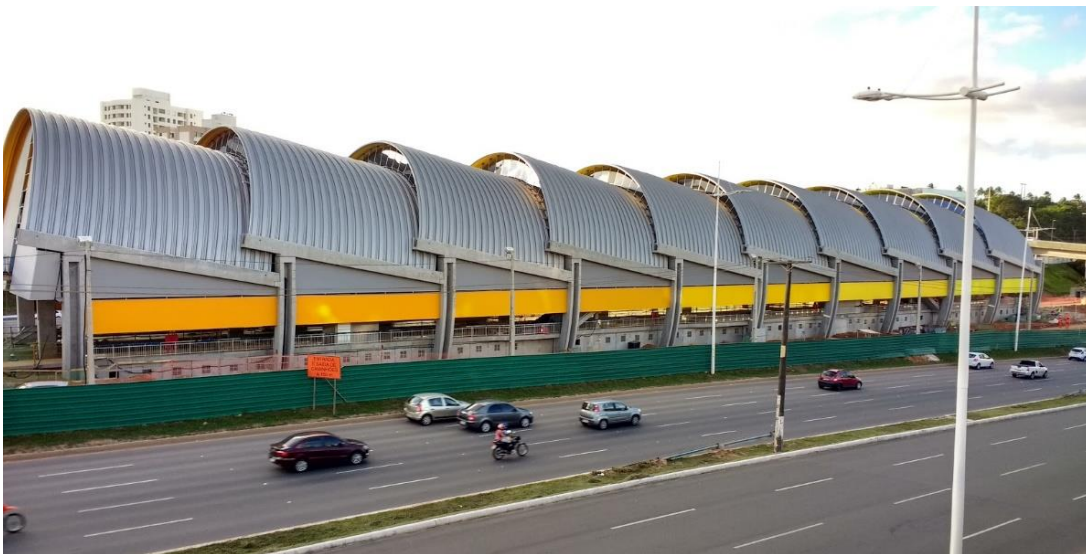
Figura 23 – Foto da Estação típica em construção (Fonte: Skyscrapercity)
