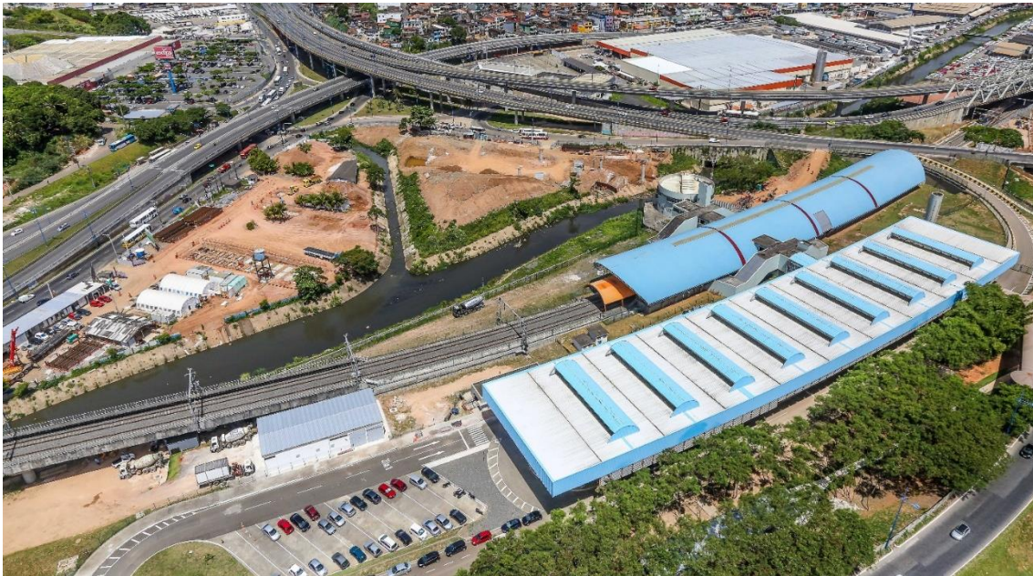
Figura 3 – Rótula do Abacaxi antes do início do projeto, com o terminal em primeiro plano e a estação Linha 1 sobre a via metroviária (Fonte: Skyscrapercity )
