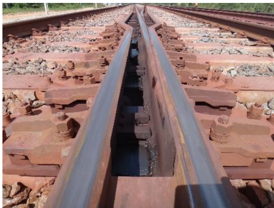
Figura 19 – Condição do trilho 60 dias depois de esmerilhado
