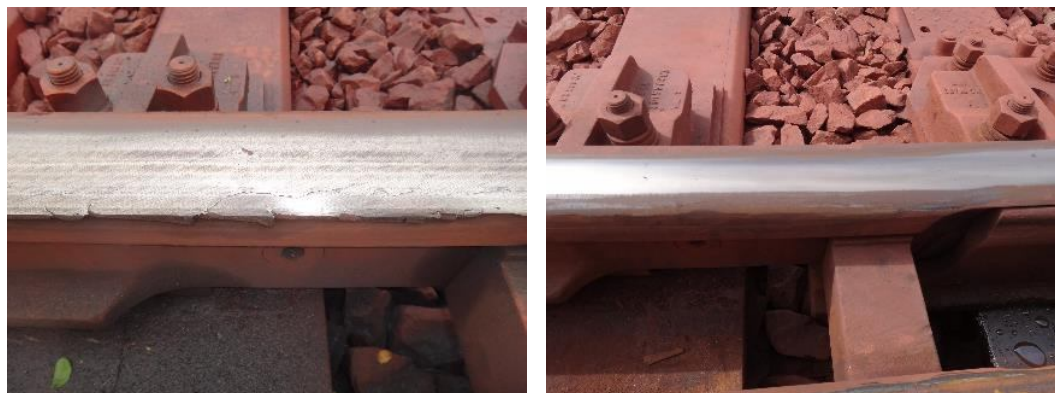
Figura 20 – Redução de desgaste na redução de bitola
