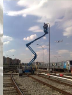
Traca de Luminárias no Pátio do Jabaquara
