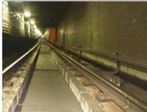
Sistema de Alimentação da Via Permanente — 3ª Trilho
