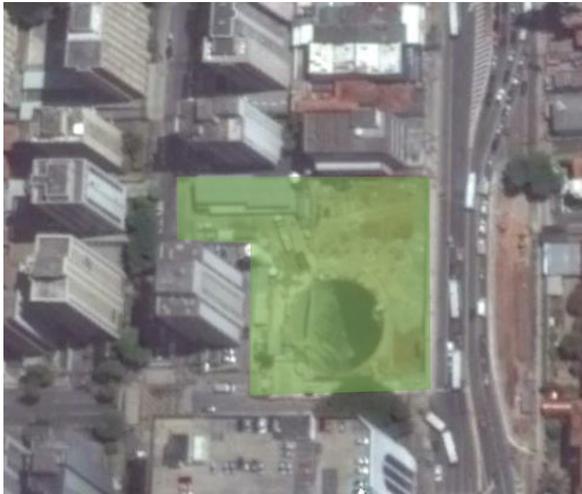
Estação Santa Cruz - Poço Fonte: Google Earth (acesso ago/2017)
