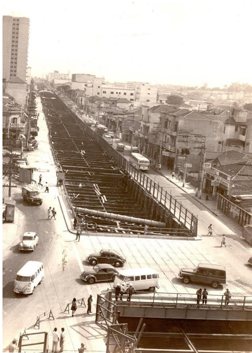
Linha 1 – túnel de via executado em VCA. Av. Jabaquara esquina com R. Carneiro da Cunha
