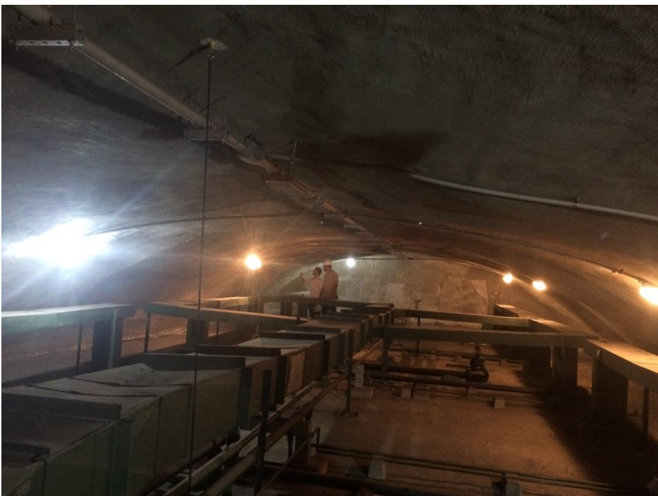
Figura: Calota túnel 2
