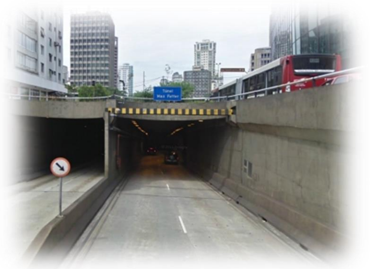
Túnel Cidade Jardim
