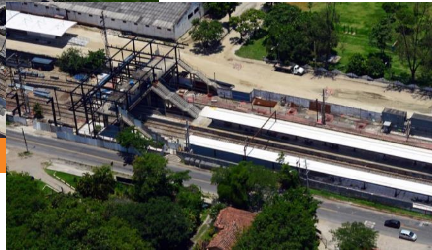
Obras de ampliação da Estação Vila Militar (Dez/2015)
