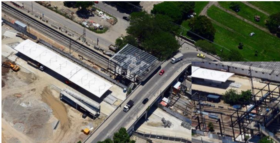
Obras de ampliação da Estação Magalhães Bastos (Dez/2015)
