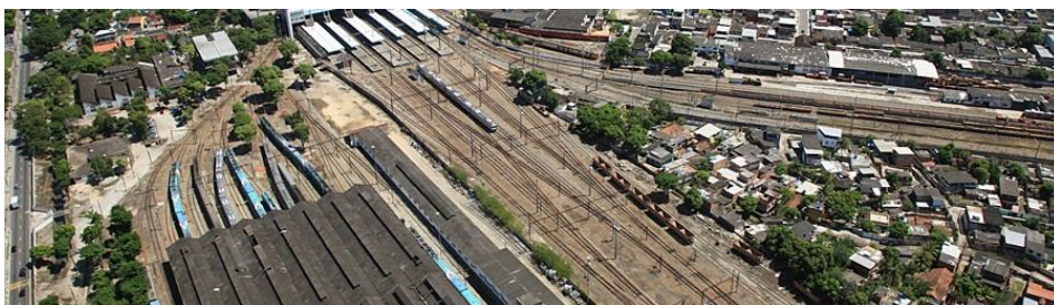
CMD Deodoro SuperVia Centro de Manutenção
