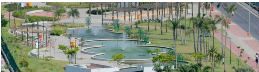
Parque Madureira Prefeitura do Rio de Janeiro Expansão Norte (Honório Gurgel) Em Obras
