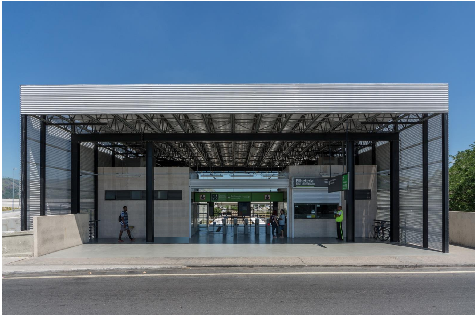
Mezanino da estação
