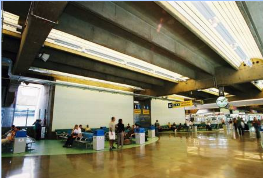
Nova iluminação Tratamento de piso
