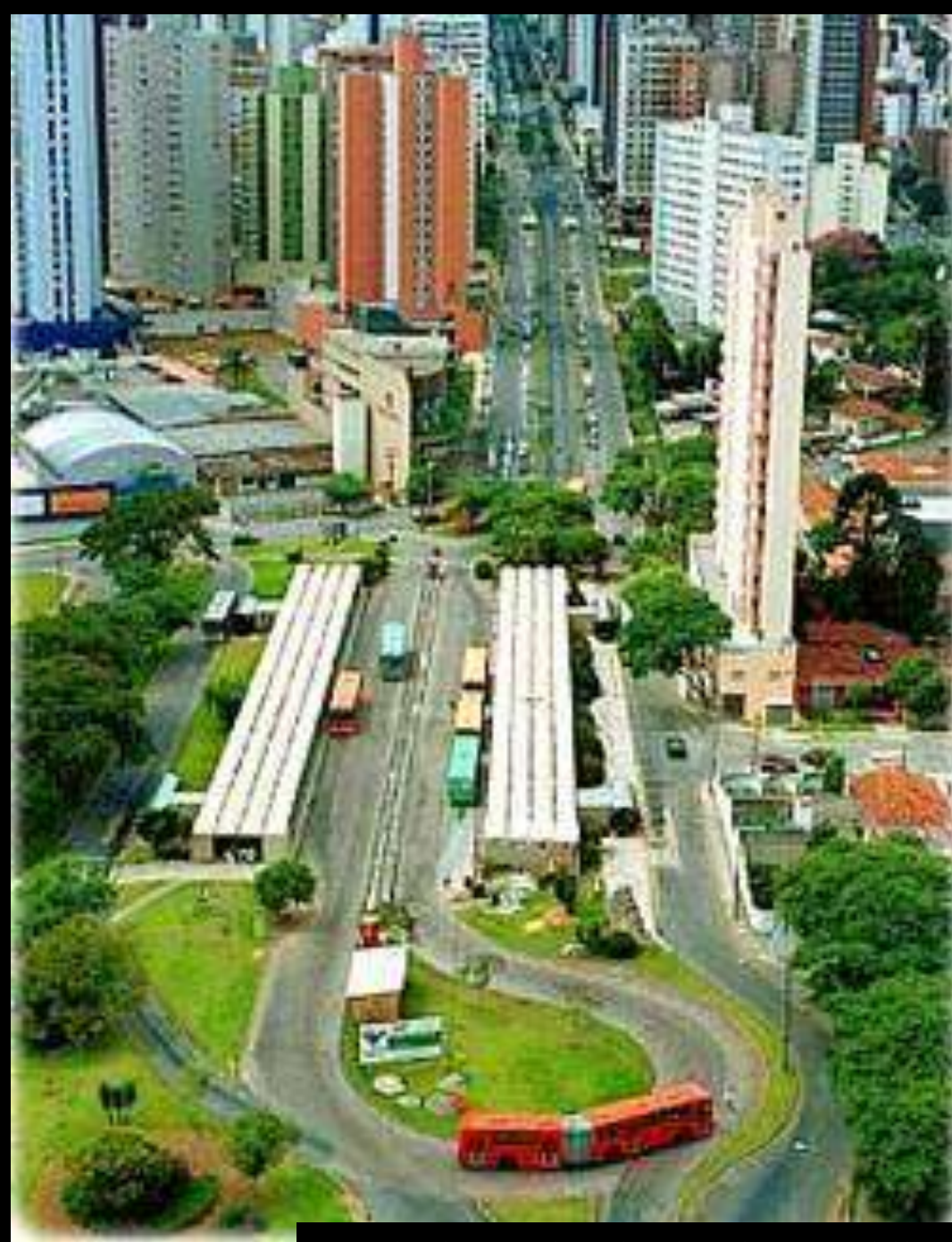
Terminal Campina da Siqueira - Curitiba
