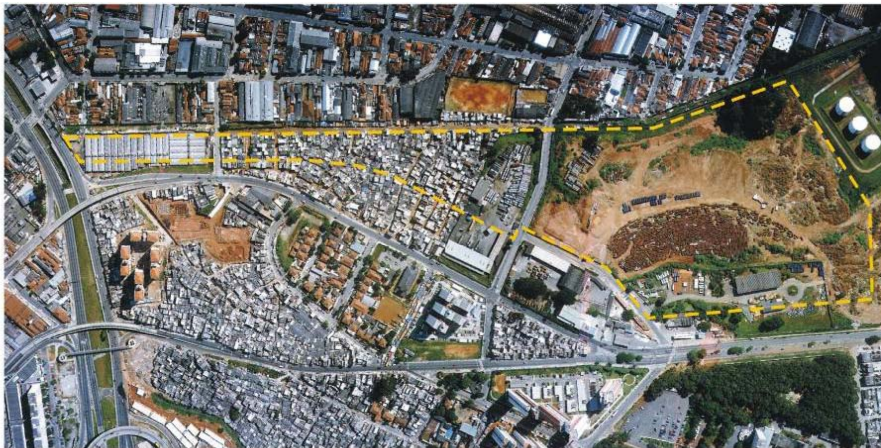
Figura 17 - Aerofoto de 2001, da mesma área, mostrando a evolução da ocupação habitacional irregular entre 1985 e 2001. Todo o trecho destinado à implantação do feixe de manobras encontra-se atualmente ocupado pela favela. No final da década de 90 um grande aterro elevou a cota da área à direita nas fotos em mais de dez metros, dificultando a implantação das vias de acesso e do feixe de manobras
