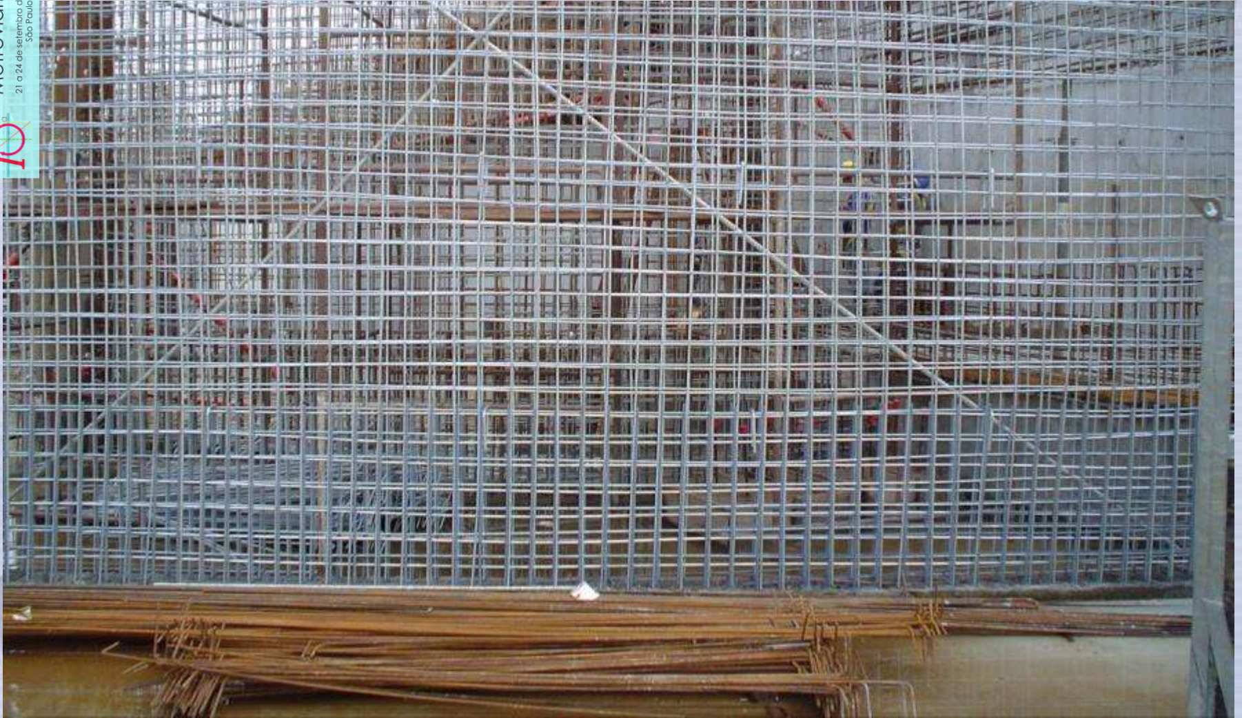
Aspecto de armação galvanizada por imersão a quente ( 28/06/04 )
