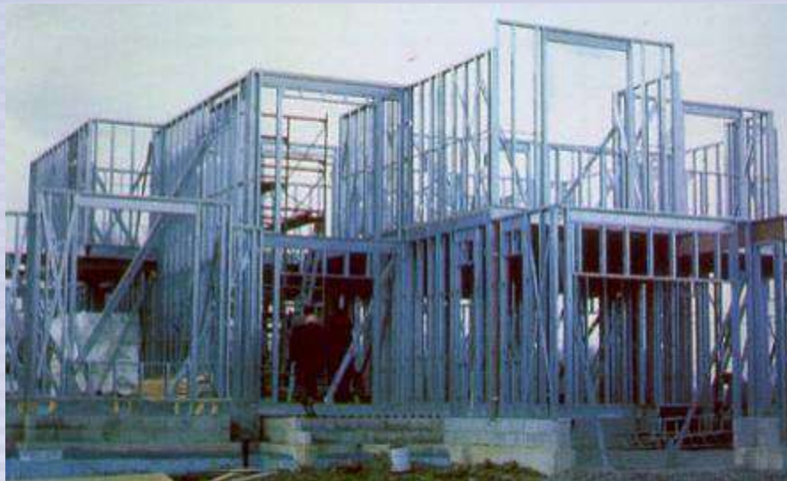
Estrutura fabril - Alemanha
