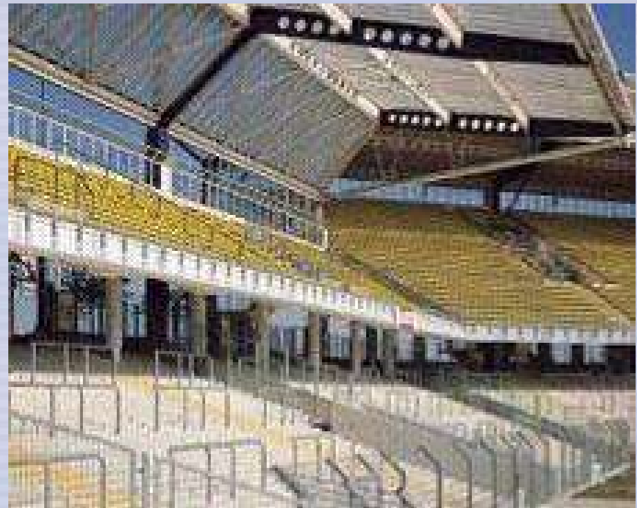
Estádio construído em aço galvanizado pintado - Canadá
