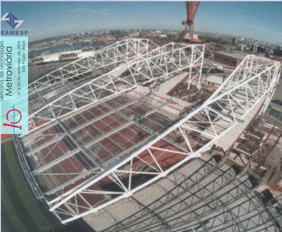
Cobertura de Estádio em aço galvanizado pintado - Inglaterra
