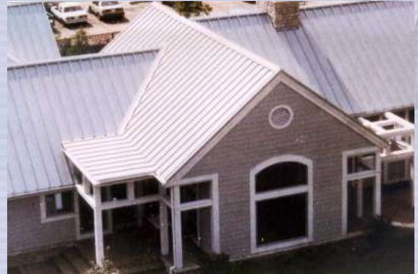
Cobertura em aço galvanizado pintado - Finlândia
