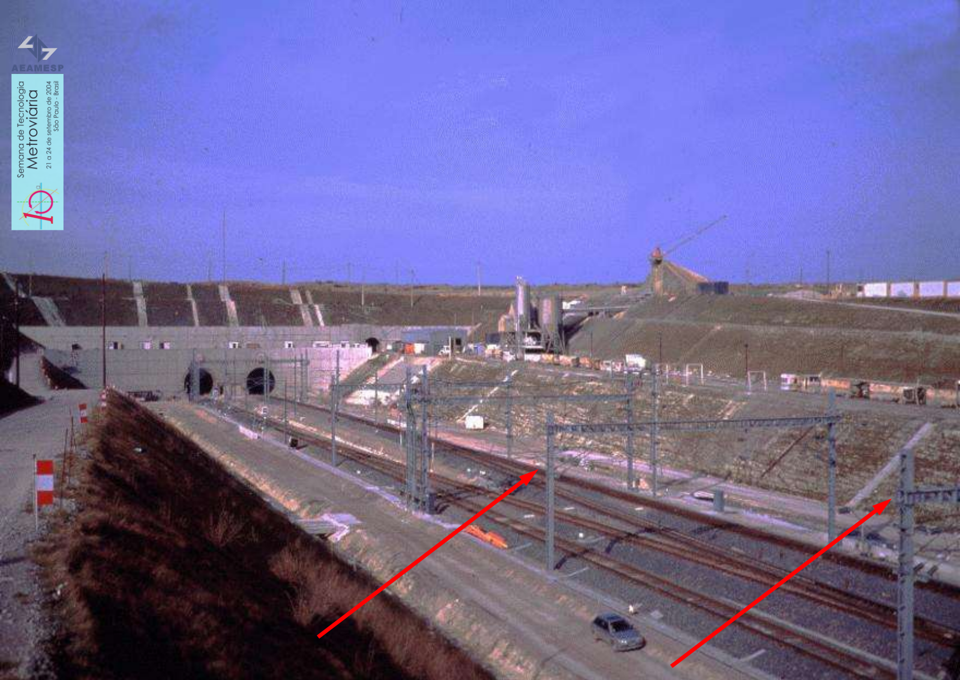
Detalhe da construção de uma das saídas dos túneis
