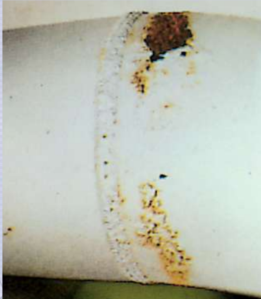
Tubulação (próximo a solda)
