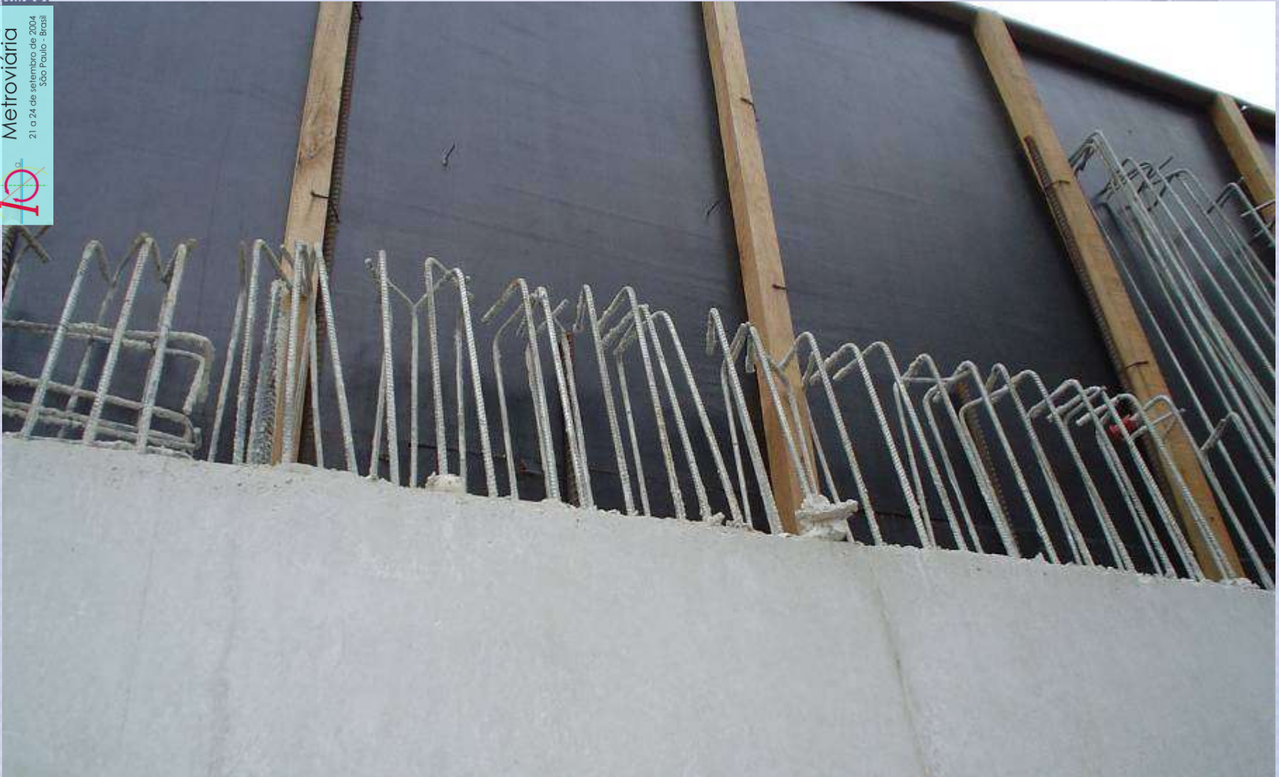
Aspecto de armação galvanizada por imersão a quente ( 28/06/04 )
