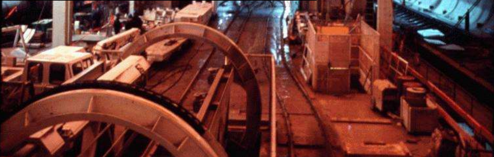
Interior da obra durante a construção
