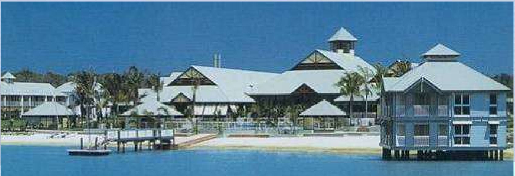
Coberturas em aço galvanizado – França
