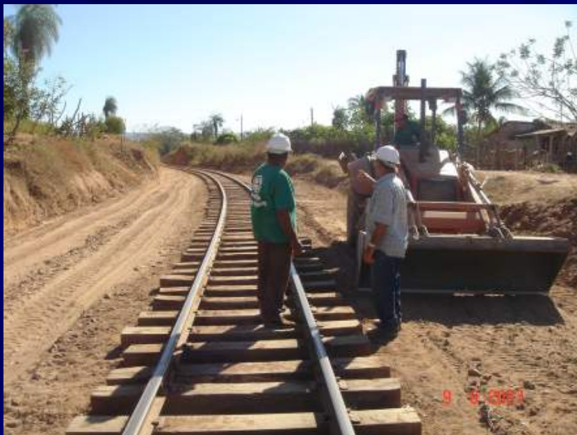
Conclusão da remoção do lastro contaminado
