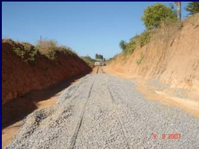
Distribuição do lastro na Via
