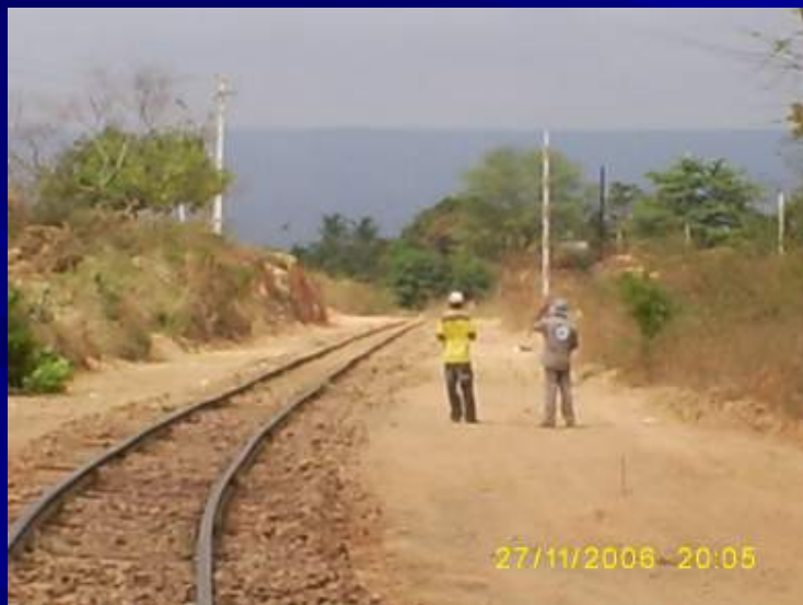
Execução de nivelamento pela Topografia
