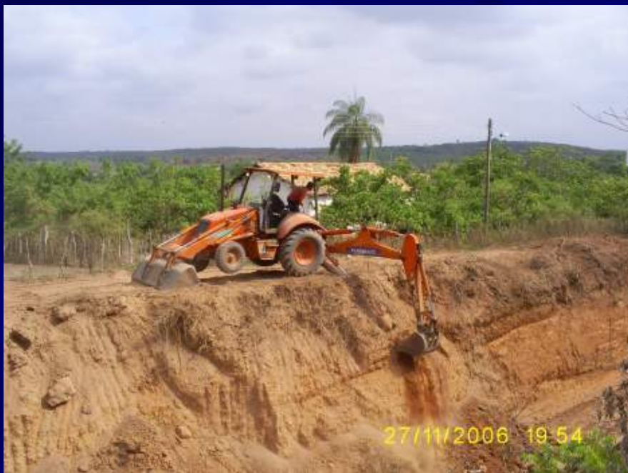
Retroescavadeira executando a abertura de talude do corte - 2ª Etapa
