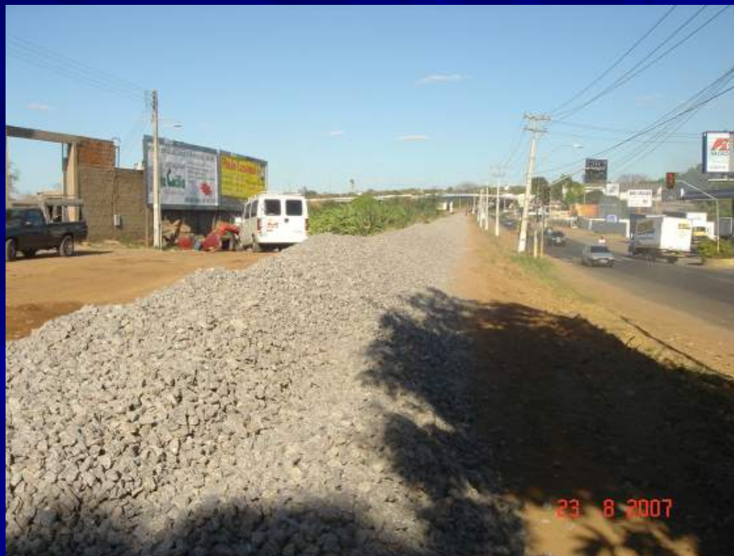
Distribuição do lastro para a nova Via
