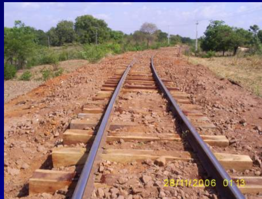
Grade ferroviária executada para lastramento, nivelamento e alinhamento da linha
