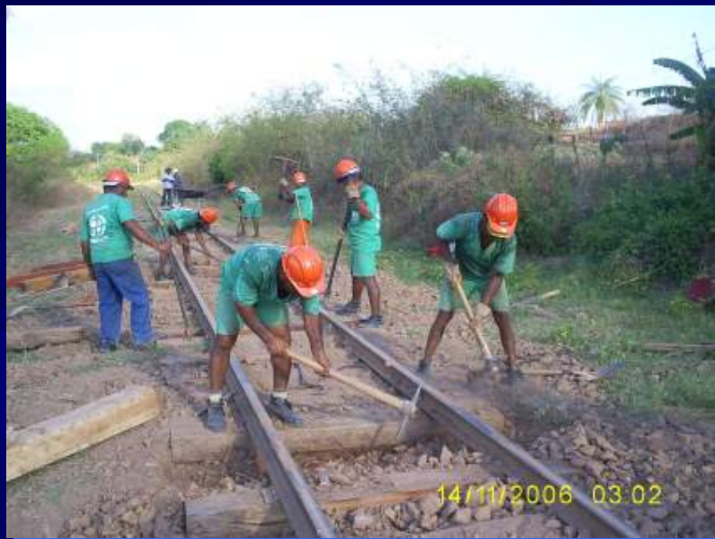
Retirada de dormentes de madeira condenados
