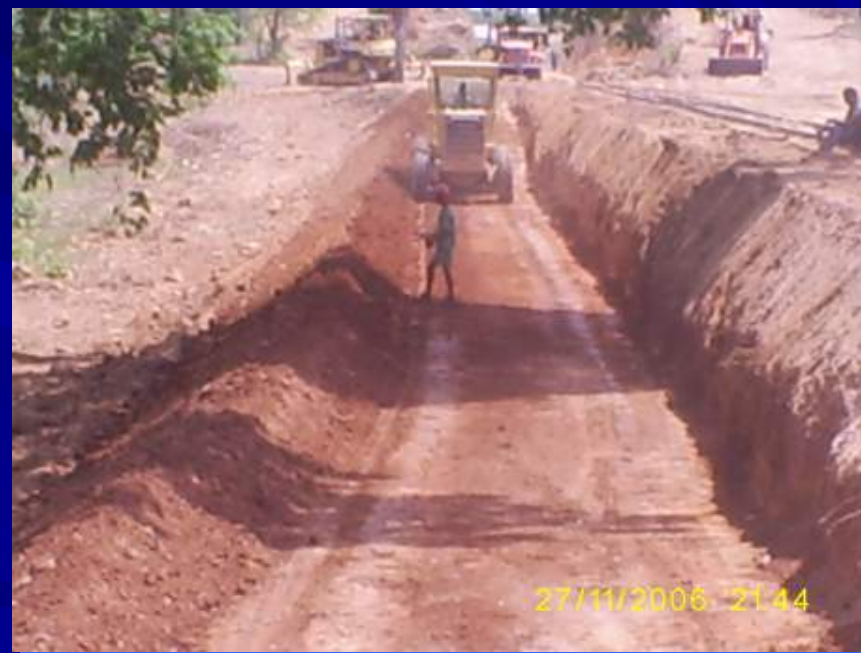
Motoniveladora executando aterro para alargamento da plataforma
