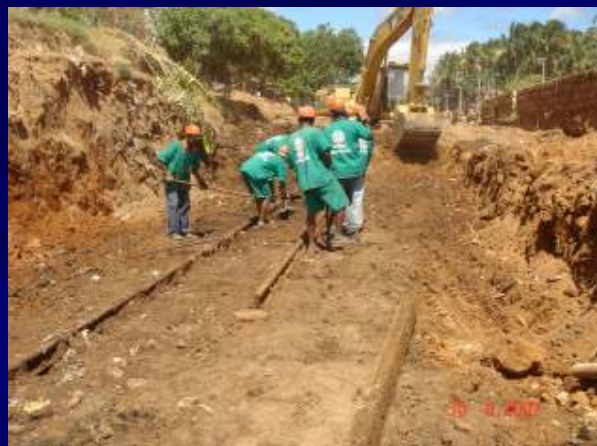
Limpeza do corte e desmontagem da Via antiga
