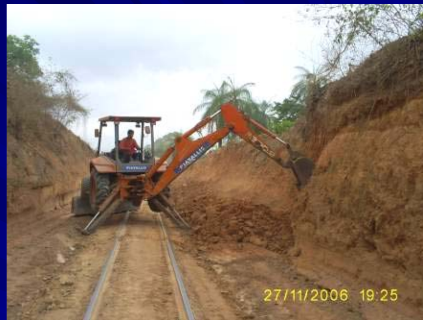
Retroescavadeira executando a abertura de talude do corte 1ª Etapa
