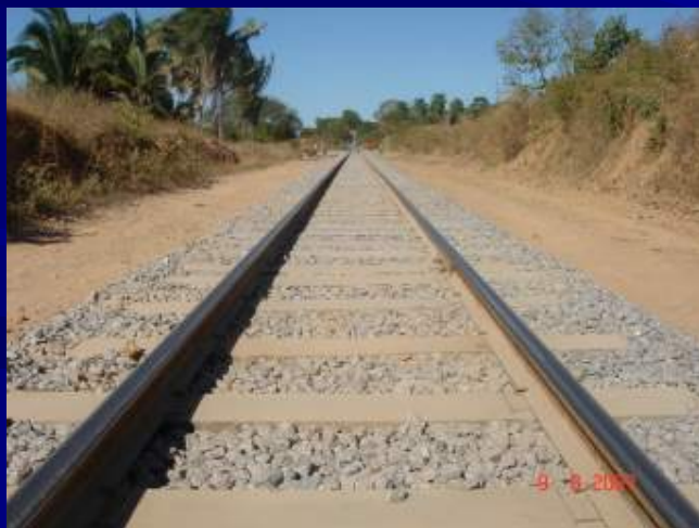
Distribuição do lastro na Via
