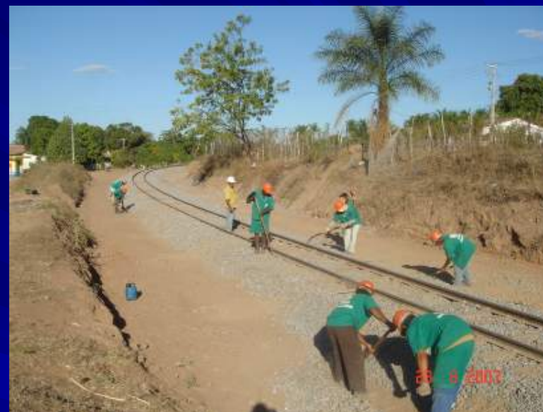
Acabamento do lastramento da Via
