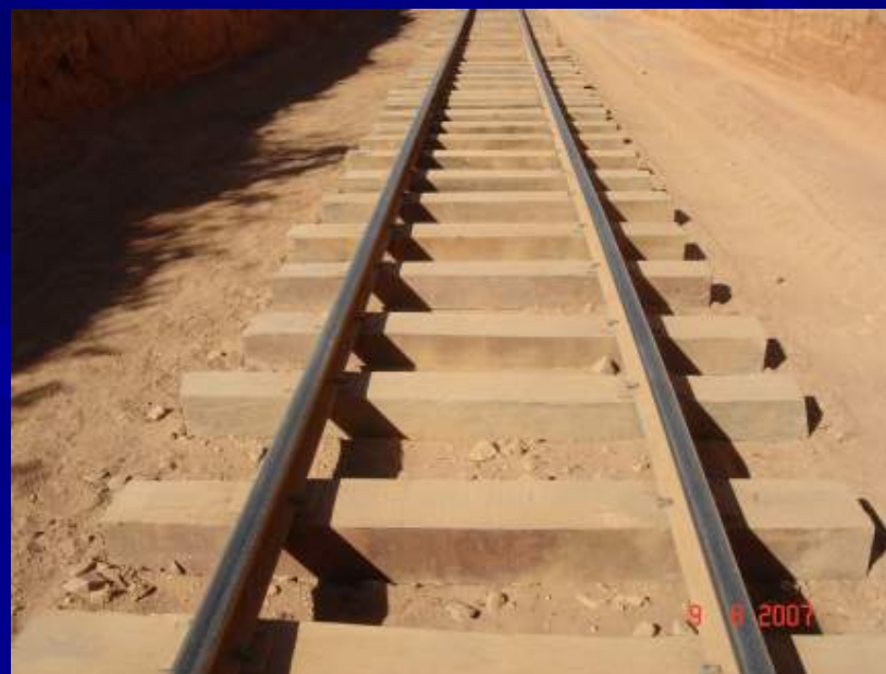
Grade da Via pronta para receber novo lastro
