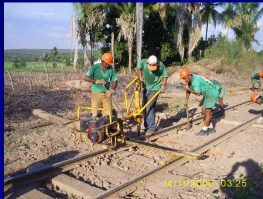
Perfuração mecânica para pregação dos dormentes
