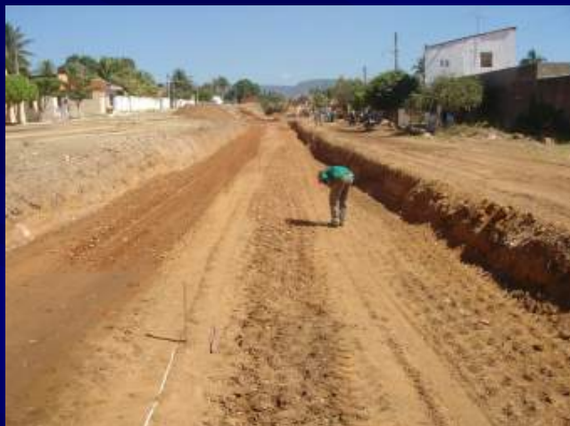
Terraplanagem da infraestrutura da nova Via
