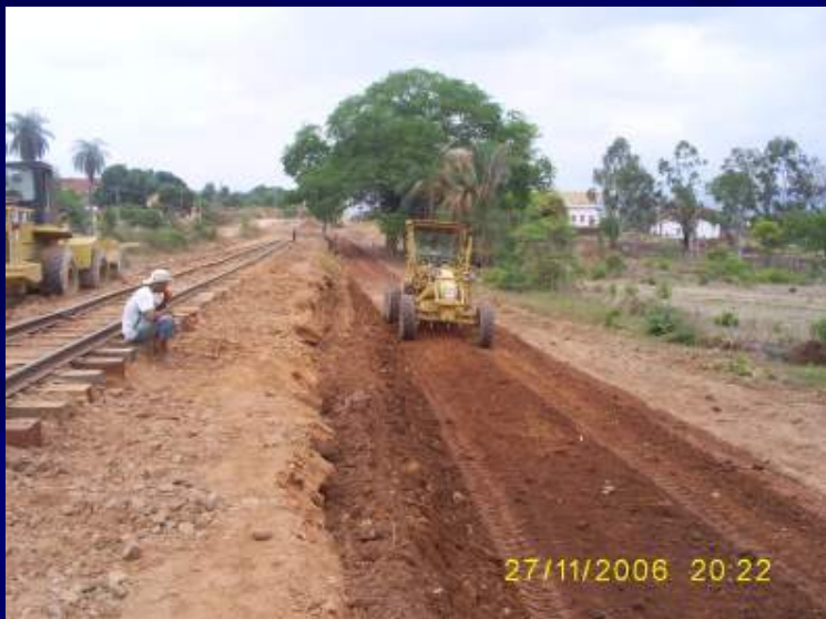
Motoniveladora executando tratamento de material para aterro
