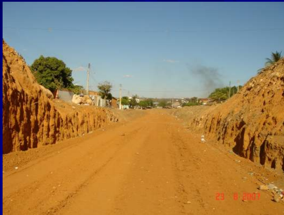
Terraplanagem da infraestrutura da nova Via
