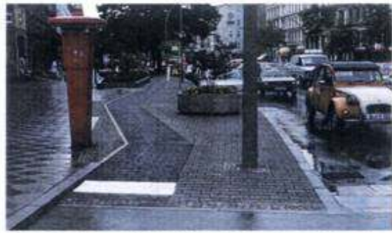
Tratamiento de pavimentación, señalización y trazado para el segmento final de una avenida en Barilo.
