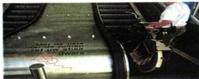
Escalera mecánica diseñada para su utilización por ciclistas en un intercambiador de transporte holandés.
