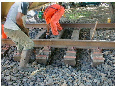
Figura 1. Esquemas e fotos das placas de aço fixadas nos dormentes.
