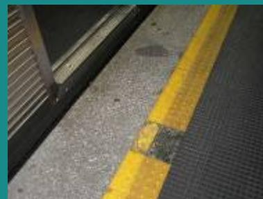
Substituição do piso tátil de alerta e pintura de faixa para destacar o vão entre o trem e a plataforma
