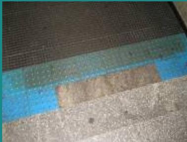
Substituição do piso tátil de alerta e instalação do piso tátil direcional
