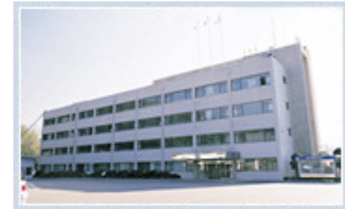
Equipamentos Elétricos - UIWANG
