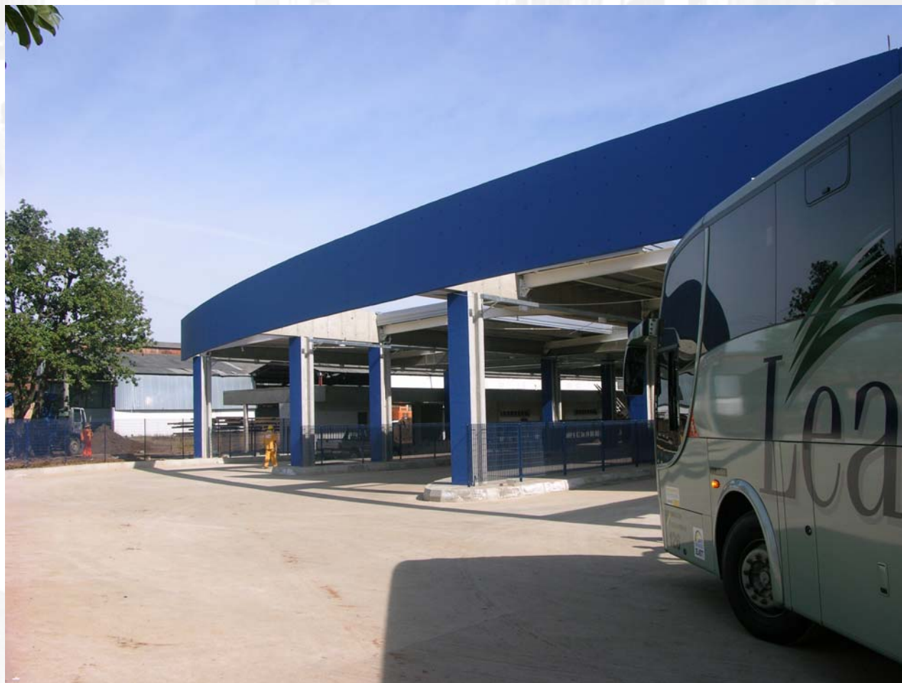
Terminal de Campinas
