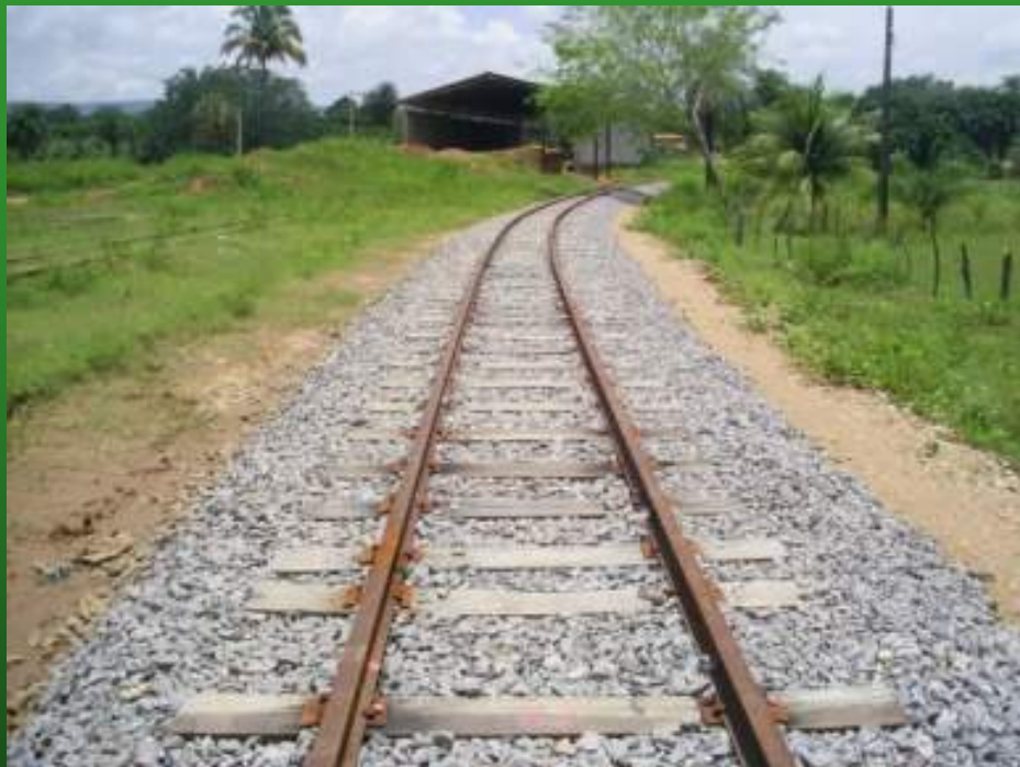
Via Permanente Concluída
