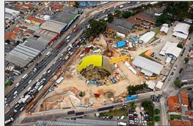
Obras da estação Vila Prudente - Linha 2 - Verde
