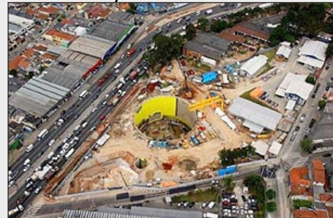
Obras da estação Vila Prudente - Linha 2 - Verde
