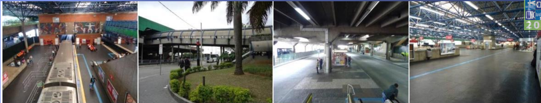
Estação "B" – plataforma, acesso, terminal urbano e mezanino. Crédito: Barbosa, M. B., 2011.
