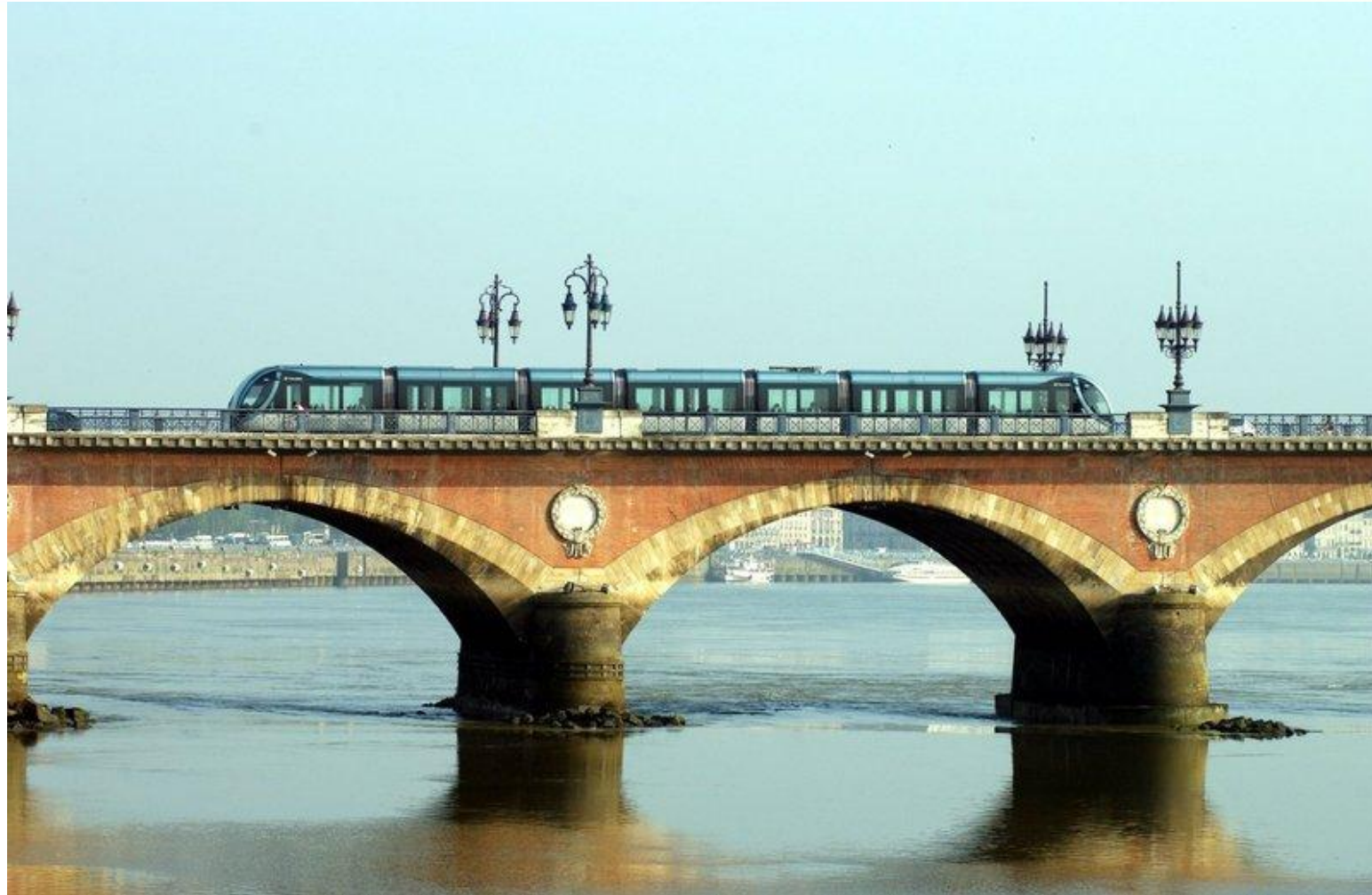
Bordeaux - 14 km de sistema sem catenária - Em operação desde 2003
