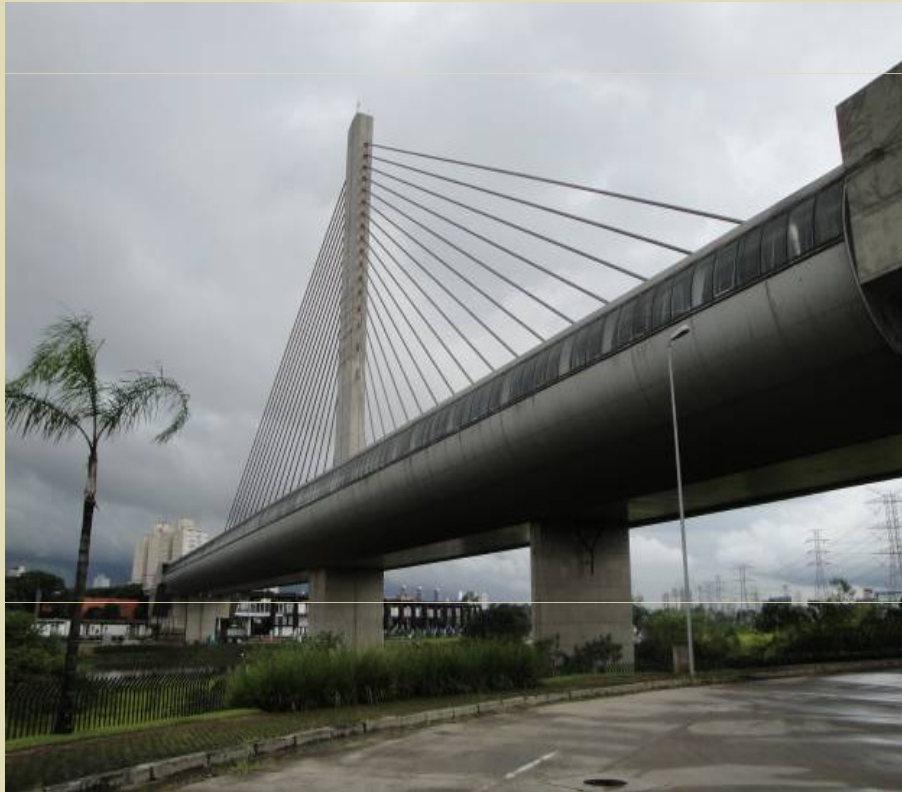
Vista geral da ponte estaiada.
