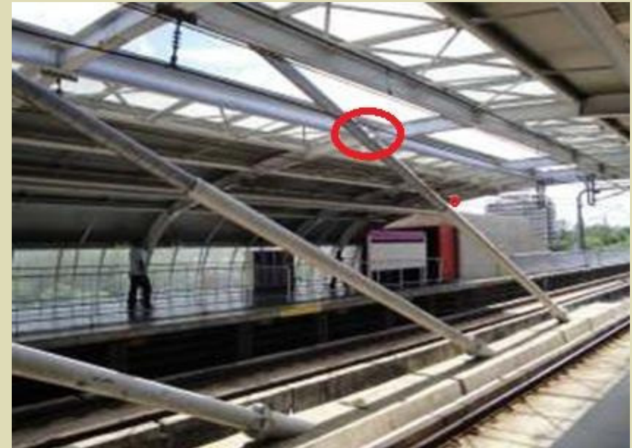
Vista do estai 317 instrumentado com os sensores, nos eixos Z 1e Y1.
