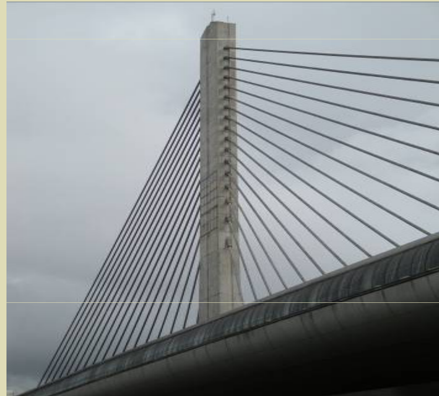
Vista geral do mastro e ancoragens.
