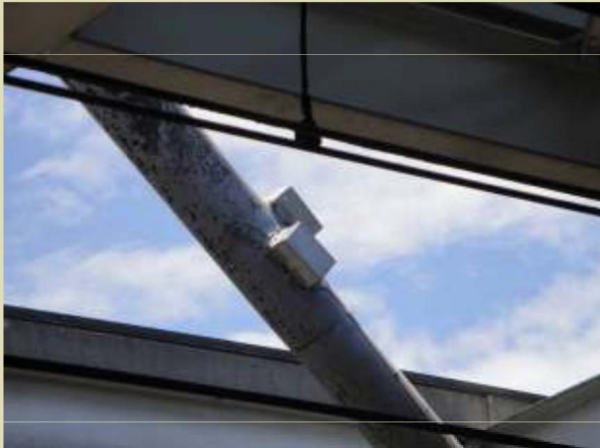
Vista dos acelerômetros no estai 304
