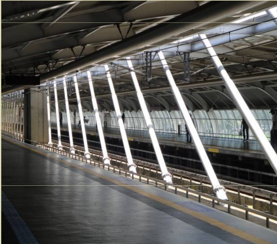
Vista geral da plataforma 01 sentido Capão Redondo.
