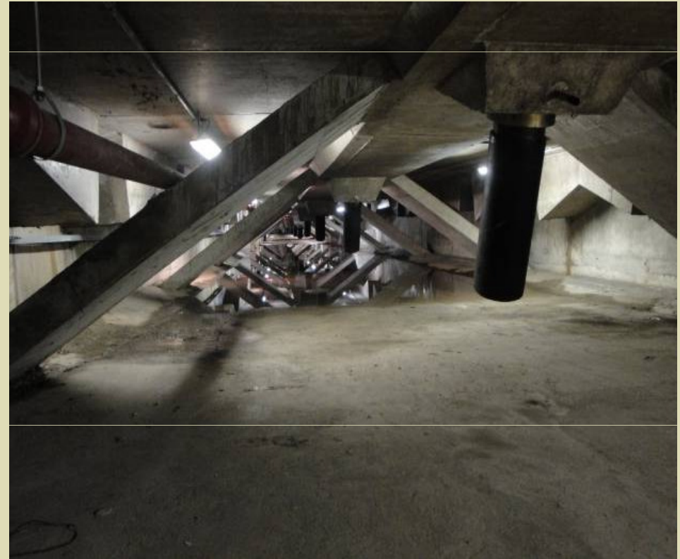
Vista geral do caixão sentido seção 317.
