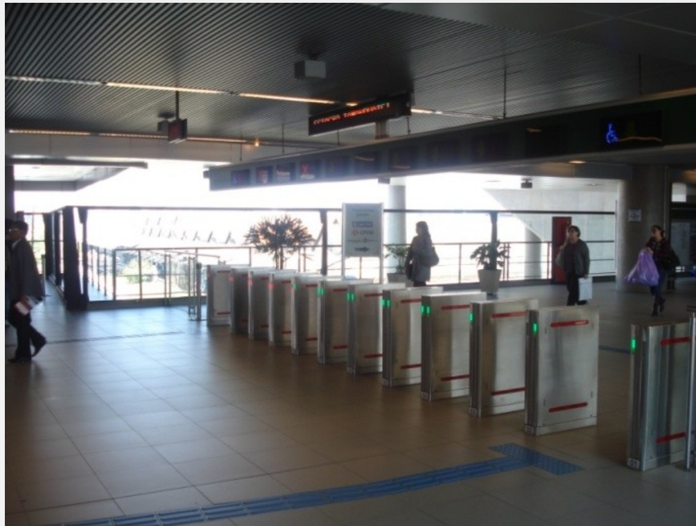
Fig. 08 – Área de transferências entre CPTM e Metrô.
