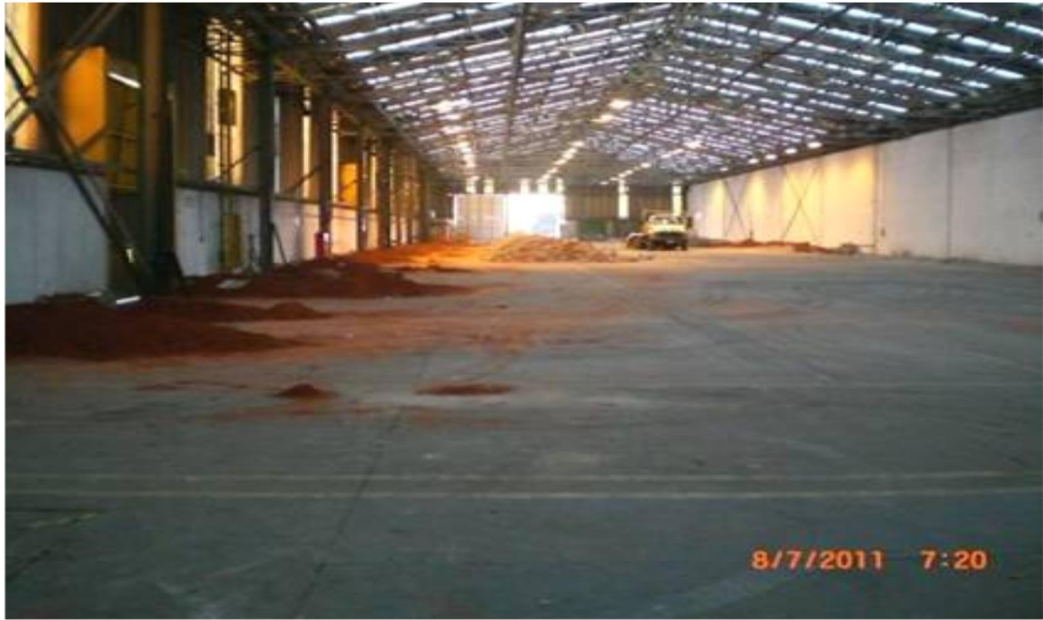
Figura 01- Obras de implantação da fábrica de Hortolândia.
