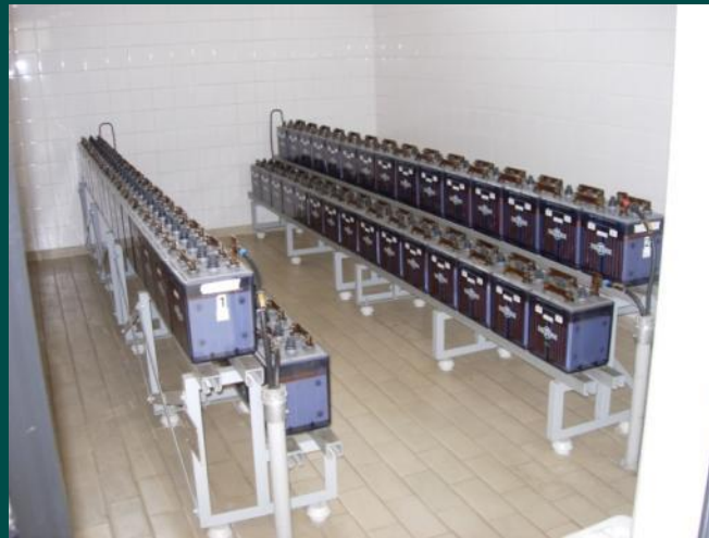
Conjuntos chumbo-ácidos de 125 Volts
