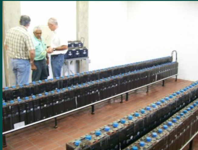
Conjuntos Alcalinos de 125 Volts 136 Ah
