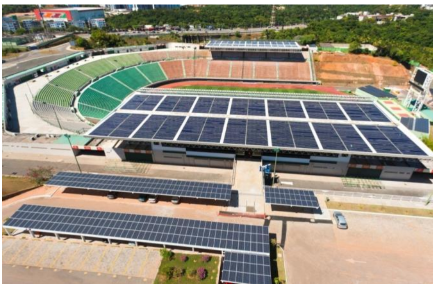
Foto 1: Cobertura das estruturas metálicas e estacionamento do Estádio de Pituaçu. (Fonte: Gehrlicher Ecoluz Solar do Brasil S.A – 2012)
