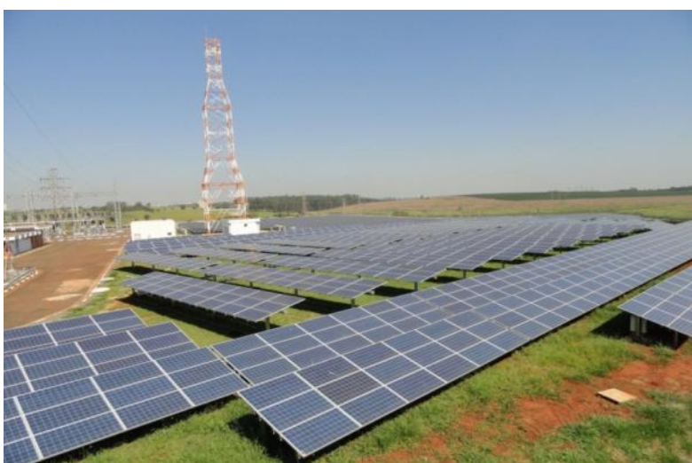
Foto 2: Usina Fotovoltaica de Tanquinho, da CPFL – Campinas SP. (Fonte: Massaru Saito – Maio/2013)
