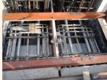
Instalação do Pintel
