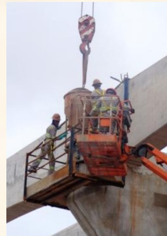
Concretagem da 3ª etapa de monolitização
