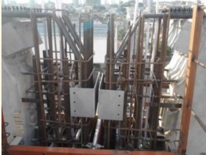
Instalação do gabarito do Finger plate
