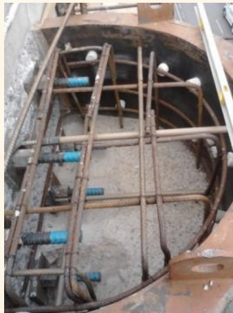
Armação da 3ª etapa de concretagem onde ficarão embutidas as barras Dywidags de protensão transversal
