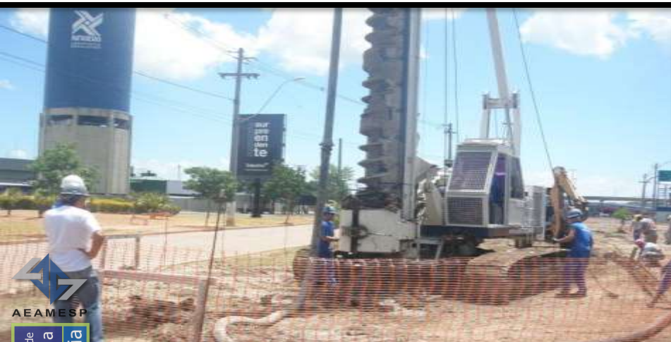
Execução de estacas hélice contínua
