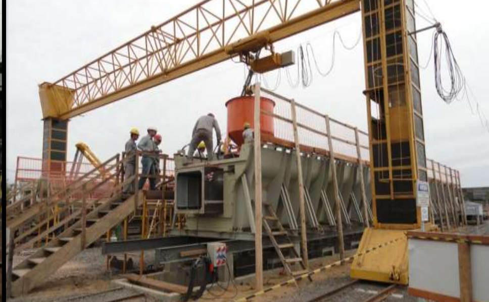
Execução de vigas pré-moldadas
