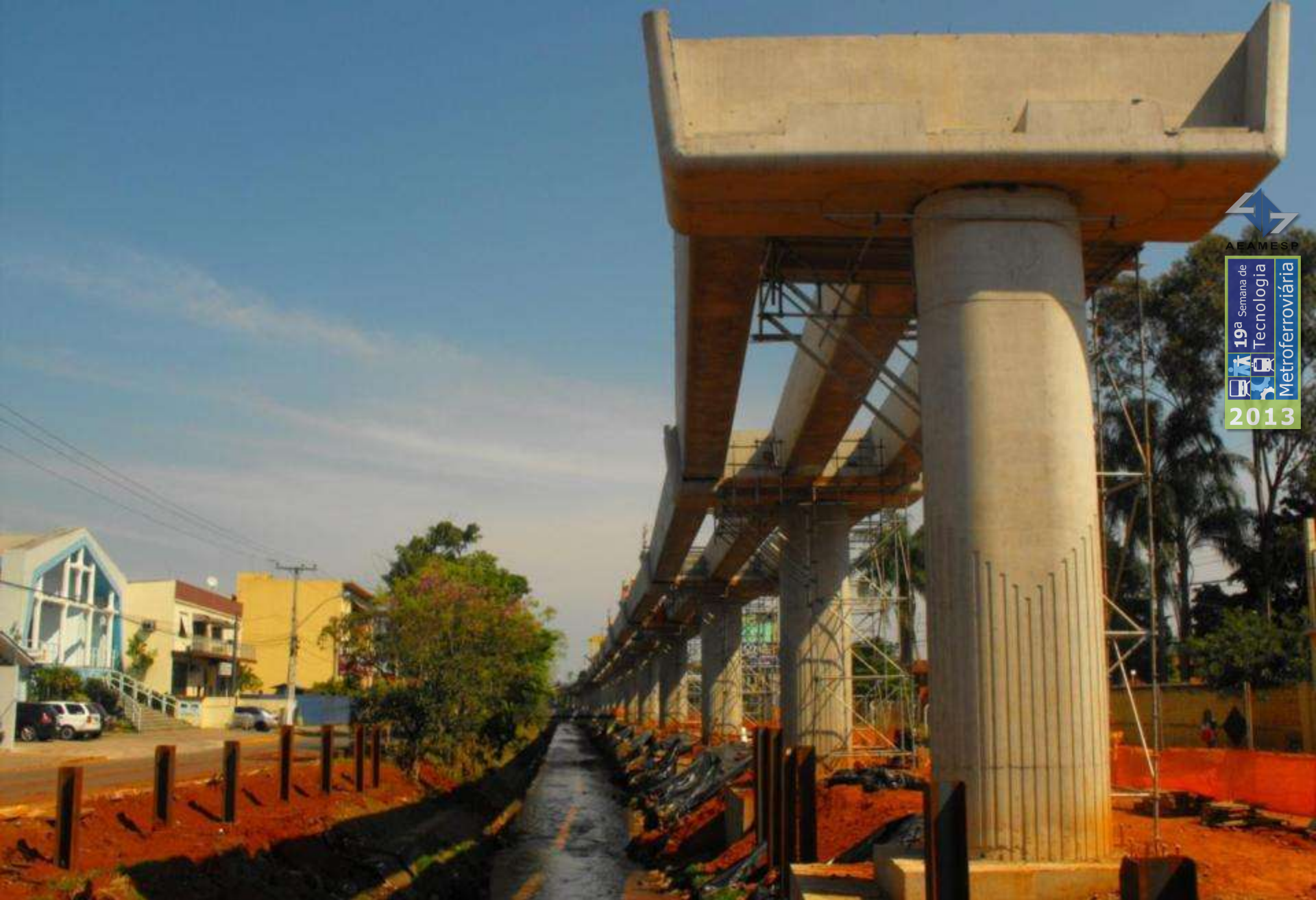
TRECHO 6 | Lançamento de vigas longitudinais em julho de 2011.
