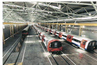
Instalações do Pátio de Manutenção
