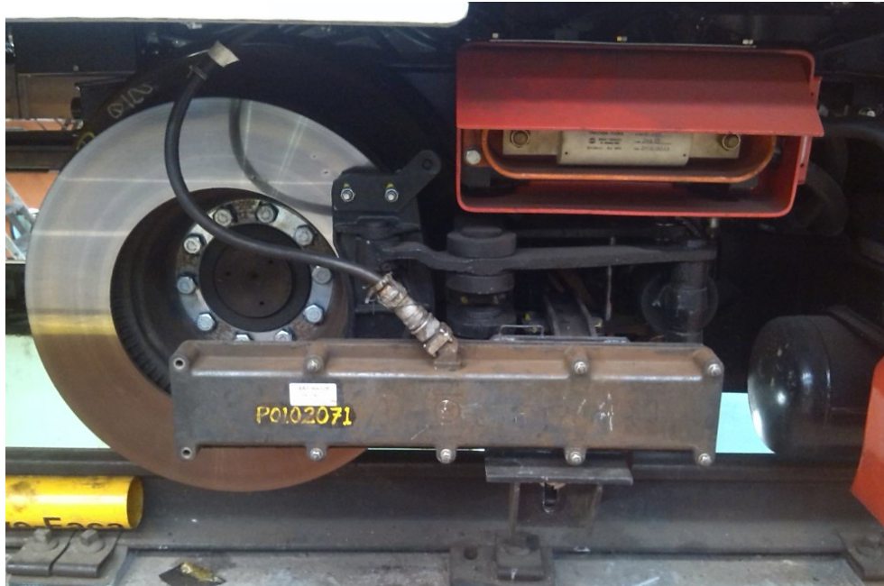
Figura 2: Montagem da antena de Parada Programada no truque
