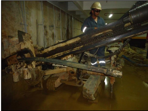
Figura 27 – Retirada do tirante T03
