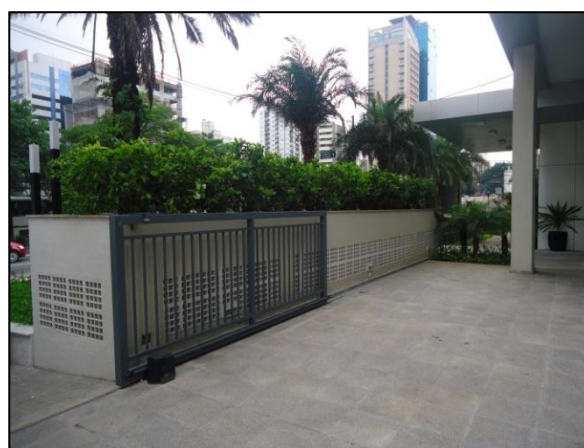
Figura 5 – Saída da ventilação no Pav. Térreo
