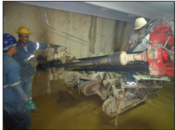
Figura 20 – Início da extração do tirante
