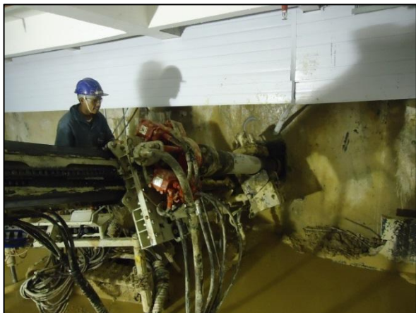
Figura 17 – Início da perfuração
