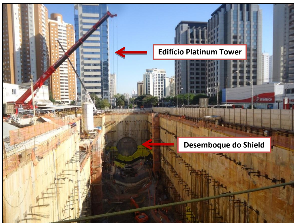
Figura 3 – VCA da Estação Moema com Edifício ‘Platinum Tower’ ao fundo.
