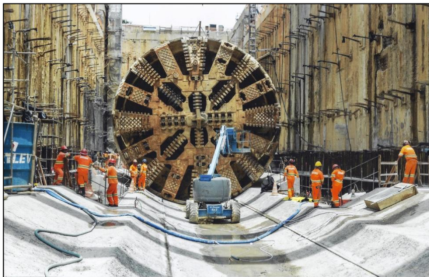
Figura 1 – Shield EPB no VCA da Estação Eucaliptos – Linha 5 Lilás
