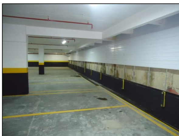
Figura 4 – Condição inicial do 4º Subsolo
