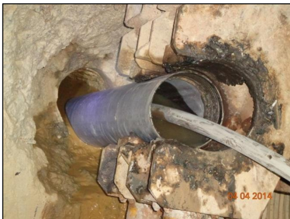
Figura 25 – Preenchimento com calda de cimento
