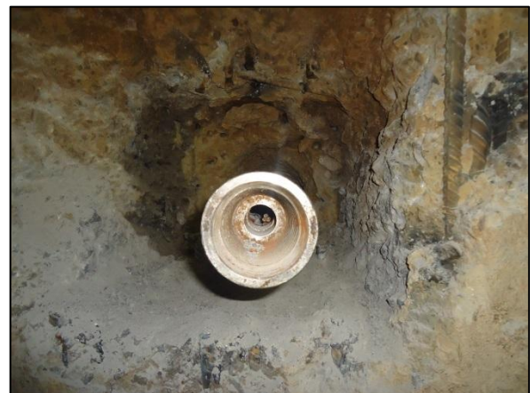
Figuras 15 e 16 – Detalhes da luva metálica soldada as cordoalhas do tirante
