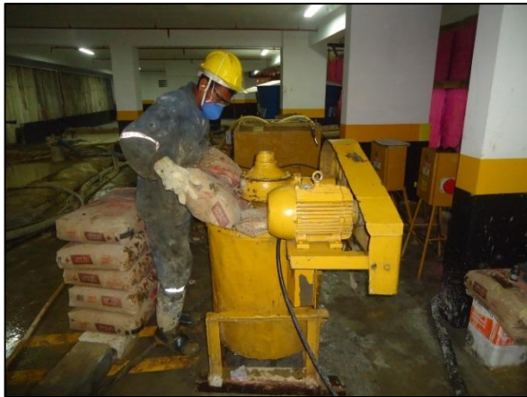
Figura 23 – Preparação da calda de cimento
