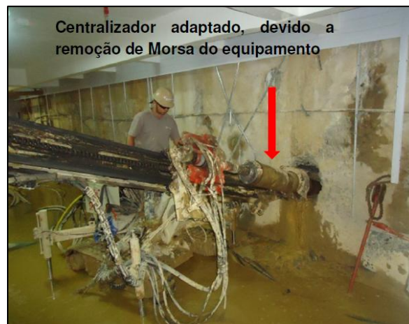
Figuras 29 e 30 – Adaptação da perfuratriz para tubo de revestimento de 8"
