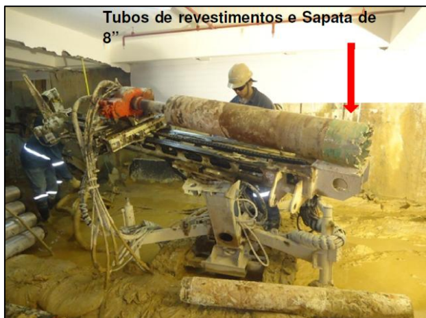
Figuras 29 e 30 – Adaptação da perfuratriz para tubo de revestimento de 8"
