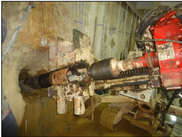
Figura 19 – Haste conectada a luva metálica
