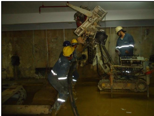
Figura 21 – Retirada do tirante
