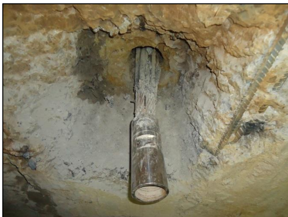
Figuras 15 e 16 – Detalhes da luva metálica soldada as cordoalhas do tirante
