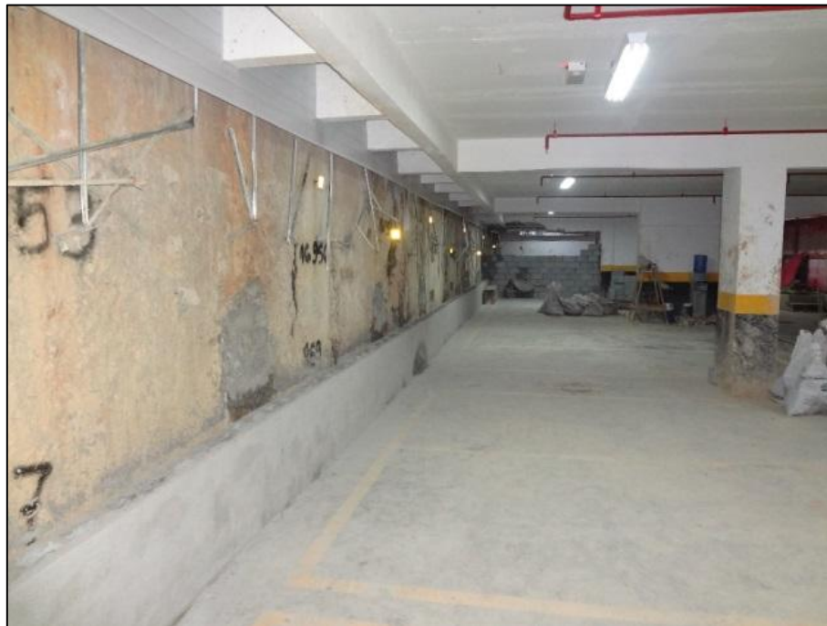
Figura 34 – Instrumentação da parede diafragma com marcos refletivos
