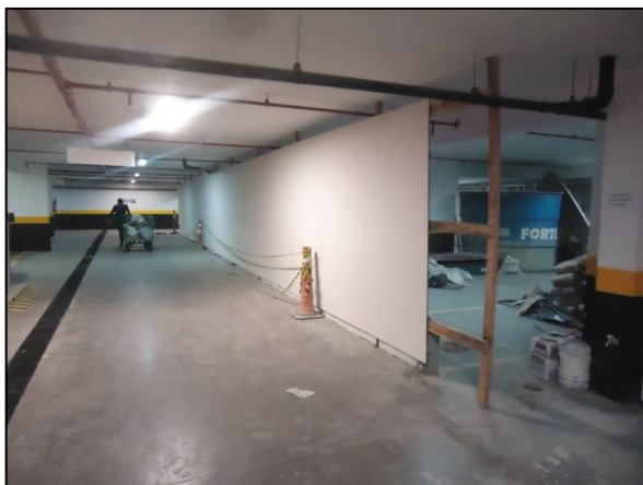
Figura 9 – Montagem Tapume no 4º Subsolo
