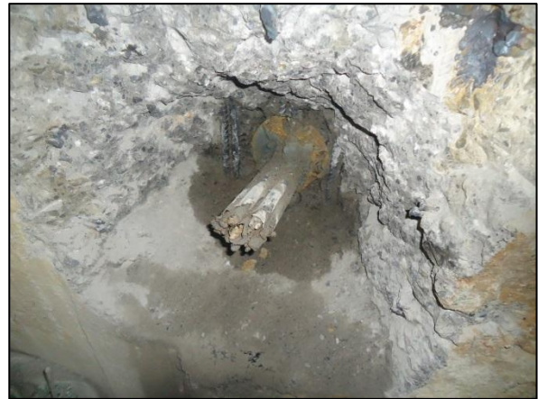
Figura 14 – Demolição para acesso as cordoalhas
