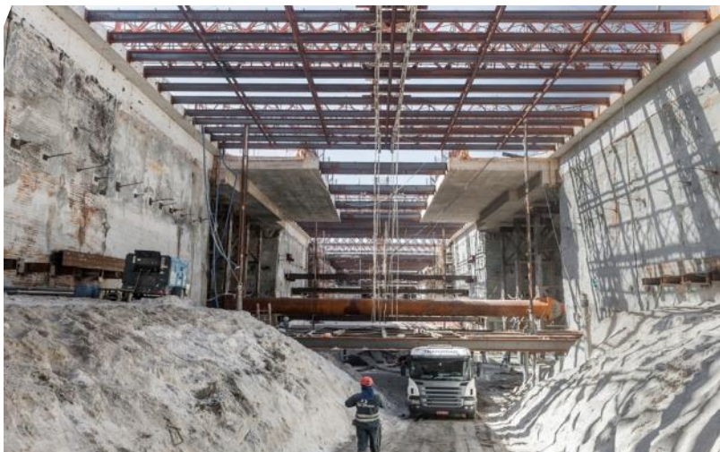
Escavações Estação Jardim Oceânico
