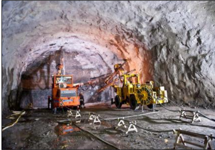
NATM – Perfuração a Fogo
