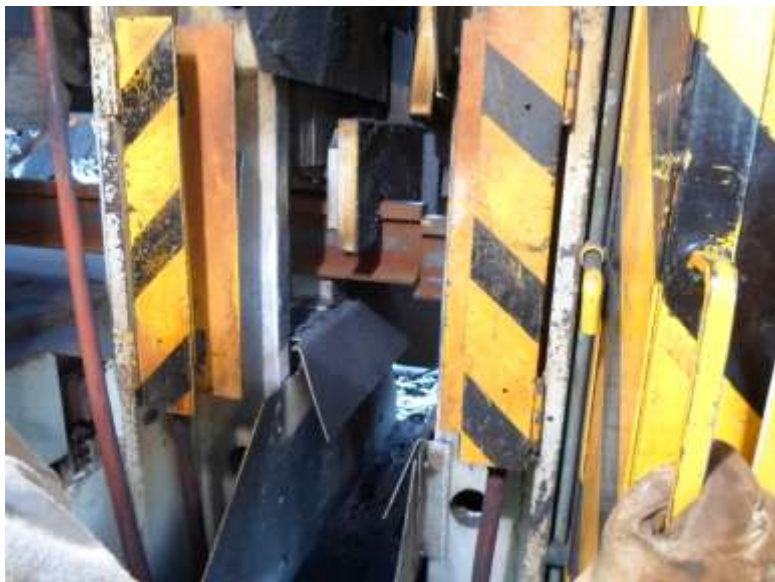
Posicionamento dos trilhos na máquina de soldagem
