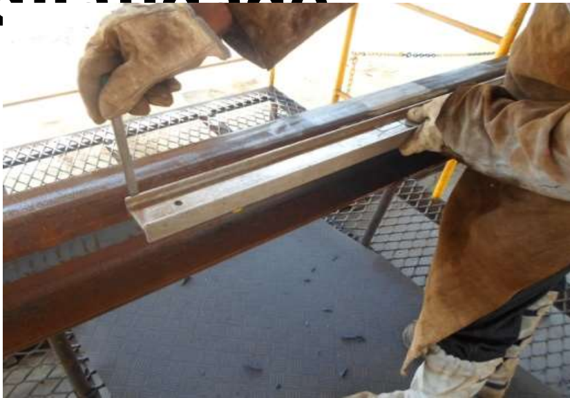
Verificação do desalinhamento do boleto
