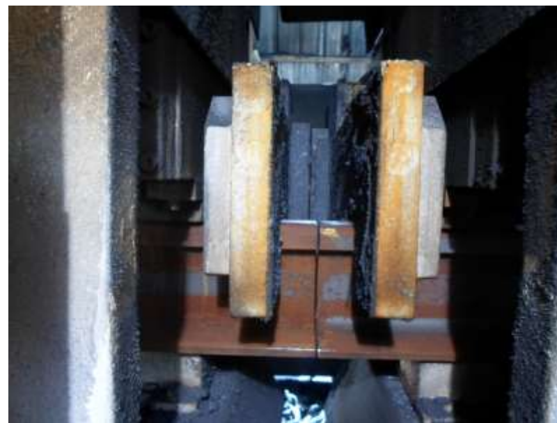
Trilhos posicionados (nivelados)
