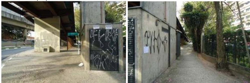
Figura 6: Visão sob a rampa vista pelo observador da Av. das Nações Unidas em direção à Av. Padre José Maria, com destaque para às áreas residuais imediatamente no entorno do acesso direto à rampa
