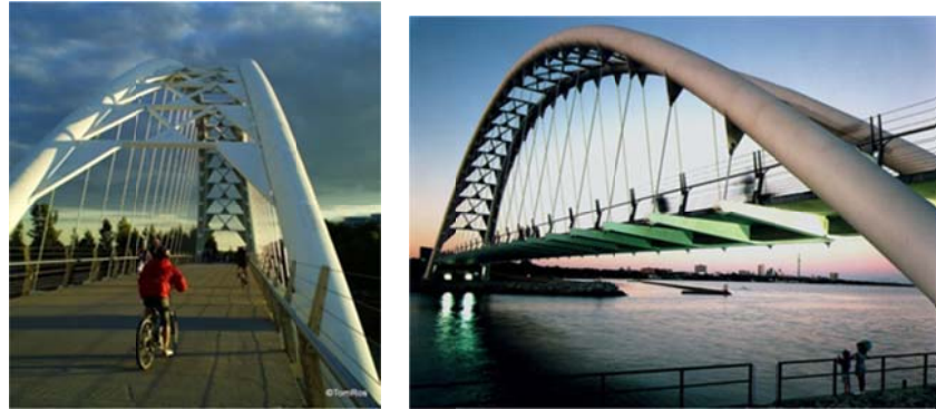
Ilustração 10: Passarela para ciclistas também: ponte que cruza o Humber em Toronto (arquitetos Montgomery Sisam)
