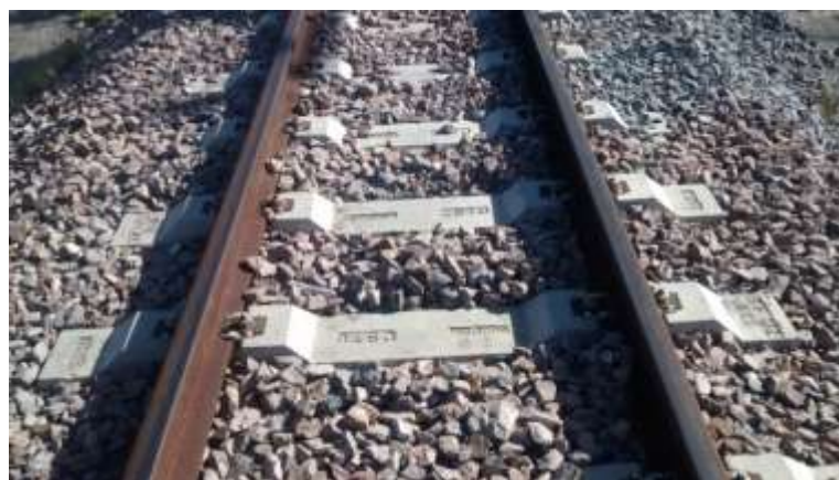
Figura 3: Dormente de concreto monobloco bitola métrica para trilho TR-45 da ENPAC
