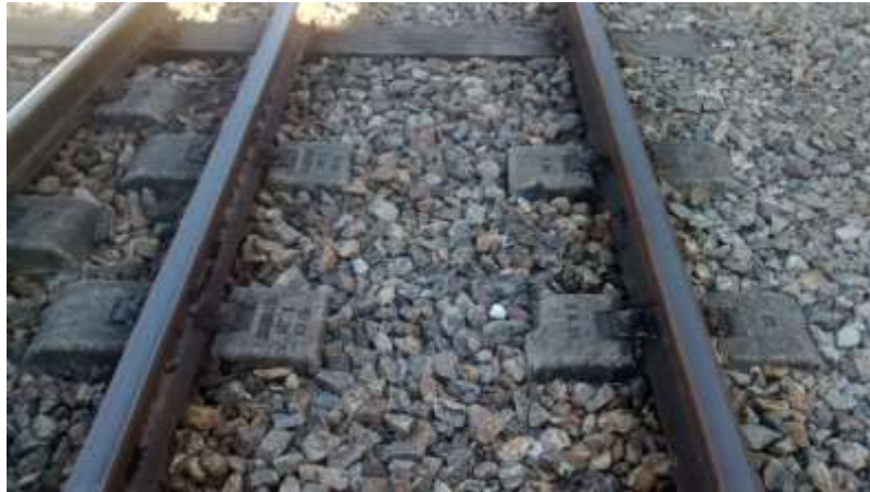
Figura 4: Dormente de concreto bi-bloco bitola métrica para trilho TR-45 da DORBRAS
