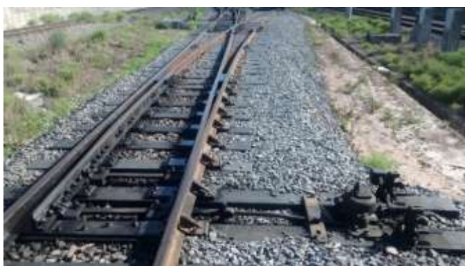
Figura 5: AMV 1:10 em bitola métrica, totalmente montado com Dormentes Poliméricos Linha Sul Diesel, outubro/2014.
