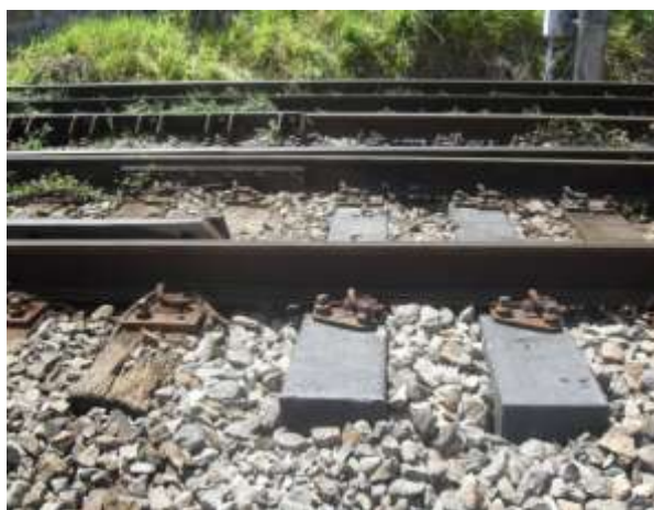
Figura 6: Dormente polimérico aplicado em AMV na ZM 5 de Cavaleiro - CBTU/STU- Recife, 2010.
